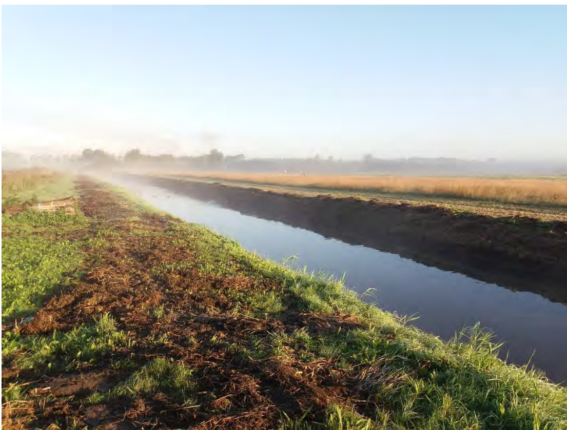
Figuur 7. Watergang parallel aan de Etnastraat na de maai- en baggerwerkzaamheden.
