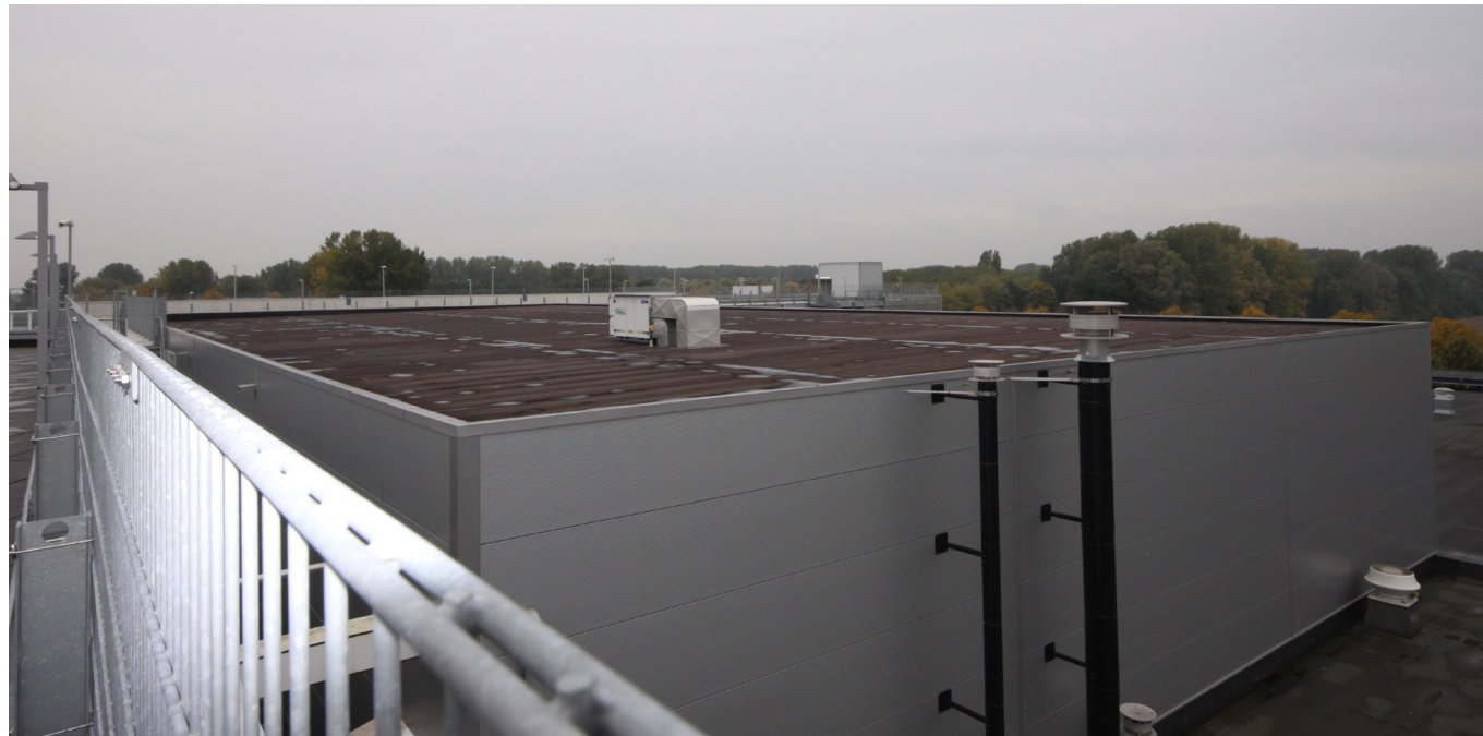
gezien vanaf parkeerdak Akerpoort II
