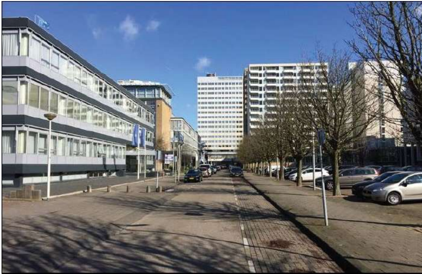
Afbeelding: parkeren langs de rijweg van het Koningin Wilhelminaplein (bron: SPvE)
