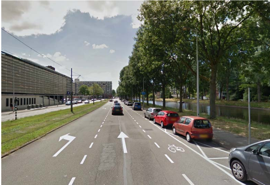
Figuur 6 Osdorpplein noordzijde in westelijke richting met linksaf opstelvak naar parkeergarage..
