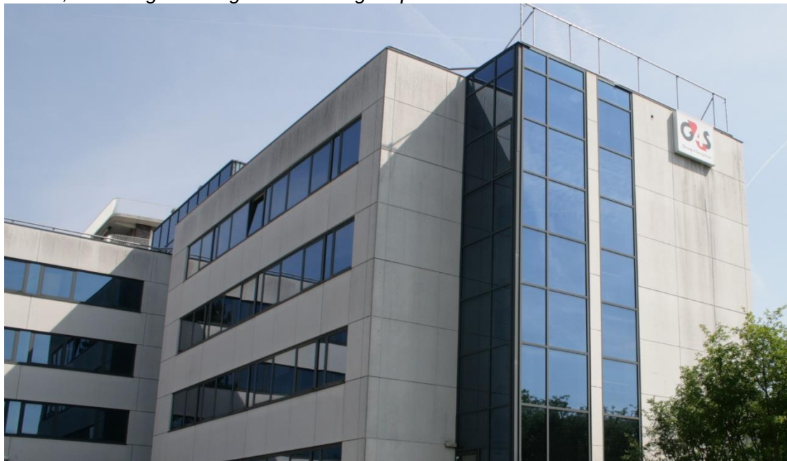
Foto 3, strakke gesloten gevelafwerking en plat dak
