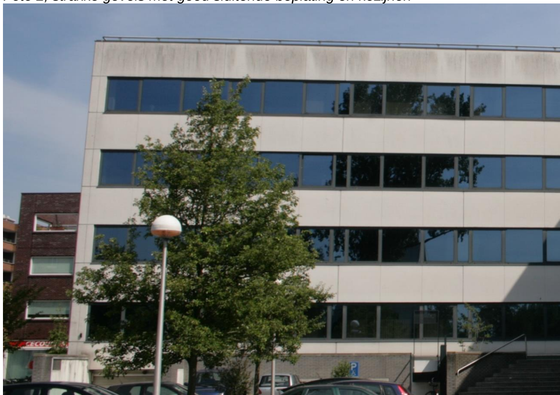
Foto 2, strakke gevels met goed sluitende beplating en kozijnen
