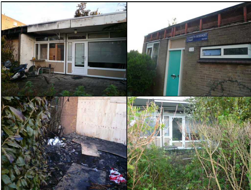
Figuur 1.4 Foto's woningen laagbouw na brandstichting (Bron: Alliantie Ontwikkeling, 2014)
