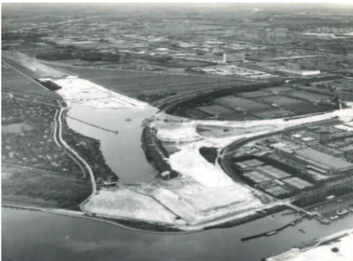
Afbeelding: De A10 en A4 en knooppunt Nieuwe Meer worden aangelegd in 1968. Op de achtergrond zijn de Oude Haagseweg en Sloterweg zichtbaar en de bedrijfsbebouwing van IBM op Johan Huizingalaan 759. Het perceel Johan Huizingalaan 761-763 was nog onbebouwd.
