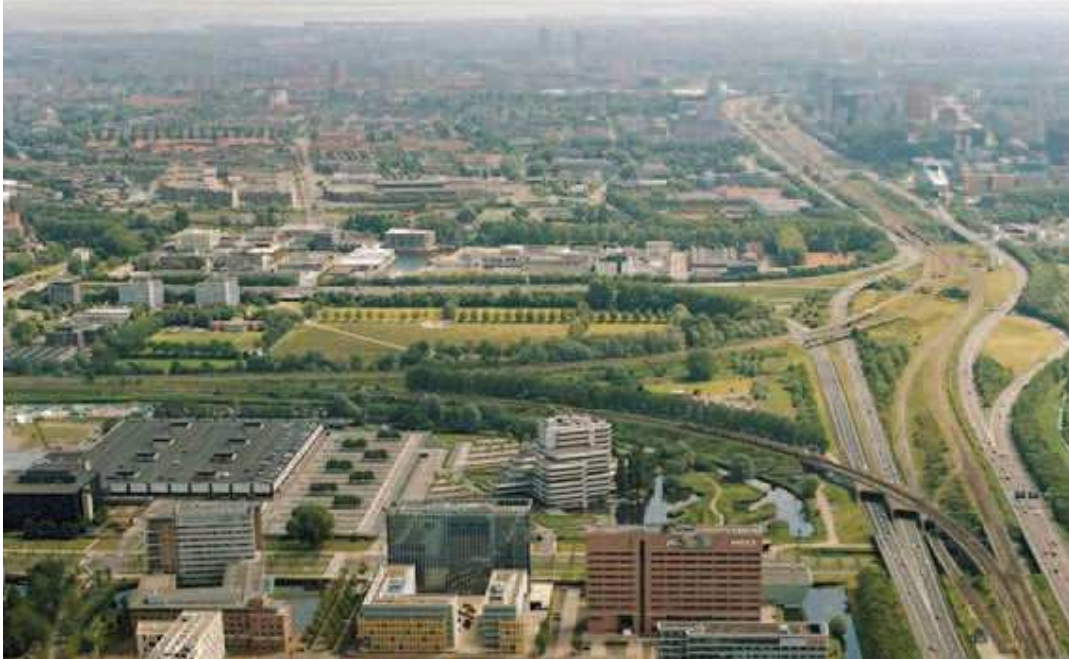
Afbeelding: Vogelvlucht rondom knooppunt Nieuwe Meer. Op de voorgrond Rieker Business Park. Daarachter aan de linkerzijde het perceel Johan Huizingalaan 761-763.
