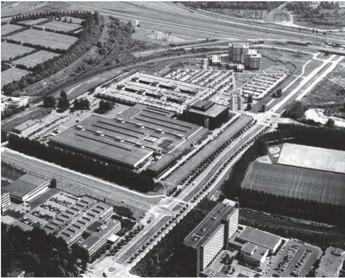
Afbeelding: de bedrijfsbebouwing van IBM gezien vanuit het noordwesten.
