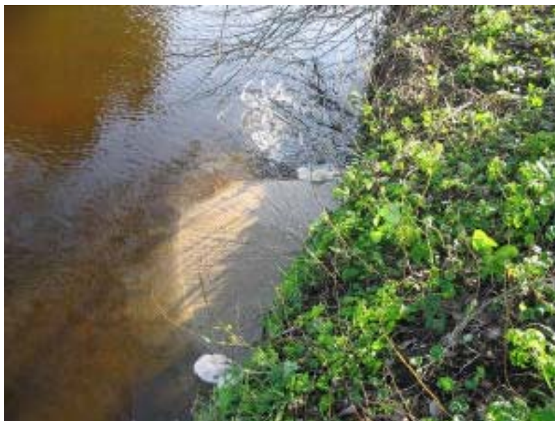
Figuur 2.3: Het water loopt bij een hoge waterstand op de Ringvaart in januari 2007 door de dijk heen, waarbij er zand de dijk uitspoelt in de teensloot.
