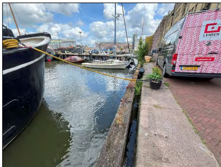
Foto 11. De dikke balk voor de stenen kademuur
