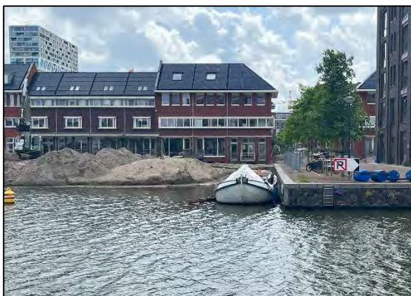
Foto 3. Kade Wilborgeiland met een deel nog te ontgraven water.
