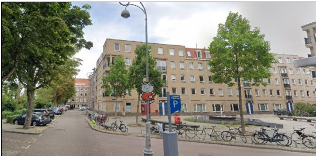
Afbeelding: een deel van de gesloten blokken aan de westrand van de Staatsliedenbuurt, gezien vanaf de hoek Visseringstraat-Buyspad (bron: Google Earth)
