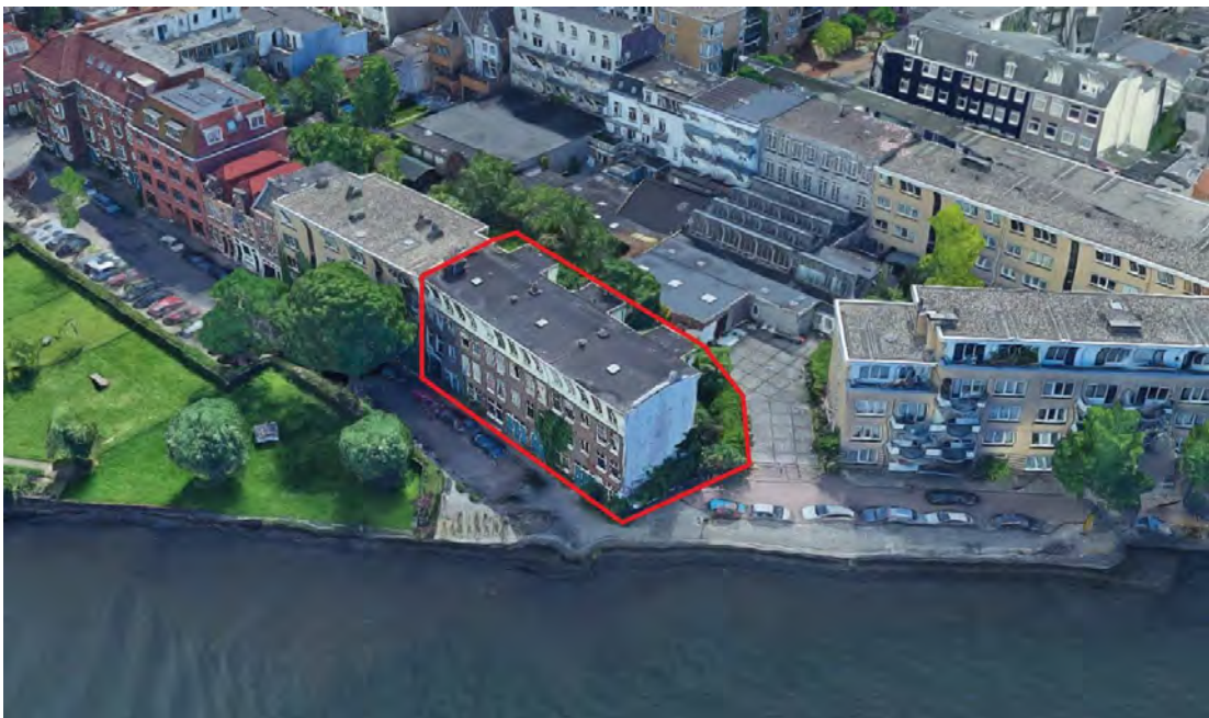
Impressie plangebied, gezien vanaf het westen (bron: Google Maps)
