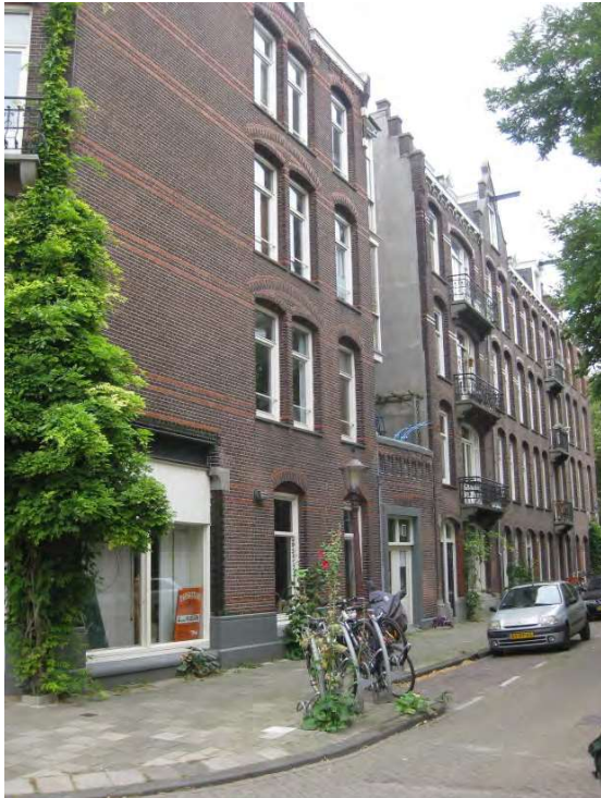
Opening voor lichtinval achter de kopbebouwing
