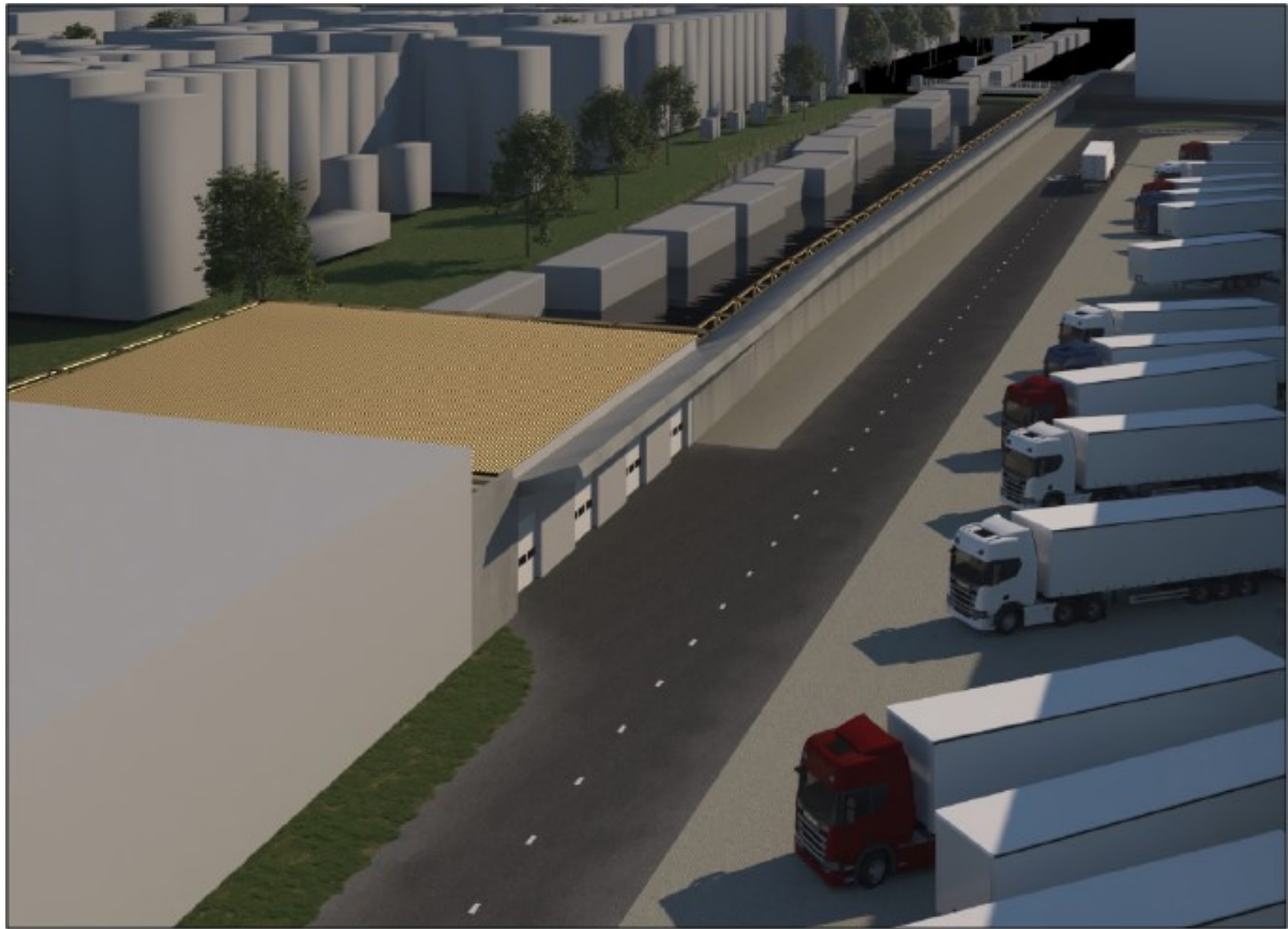
Afbeelding: visualisatie geluidscherm met luifel overhang langs de oostelijke expeditiestraat
