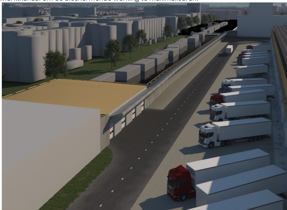
Figuur 3.3: visualisatie gebouw tbv koelwagens en geluidscherm langs Oostelijk Marktkanaal
