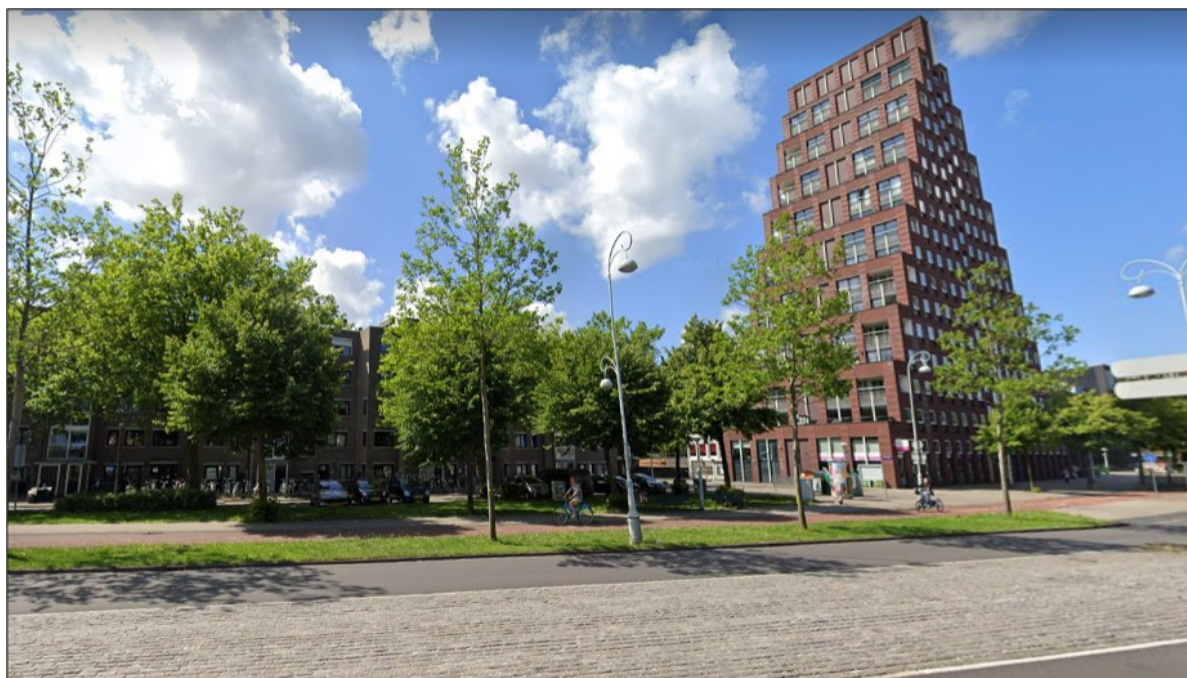
Afbeelding: de aan de overzijde van de Jan van Galenstraat gelegen woonbebouwing in de Marcantibuurt (bron: https://www.google.nl/maps )
