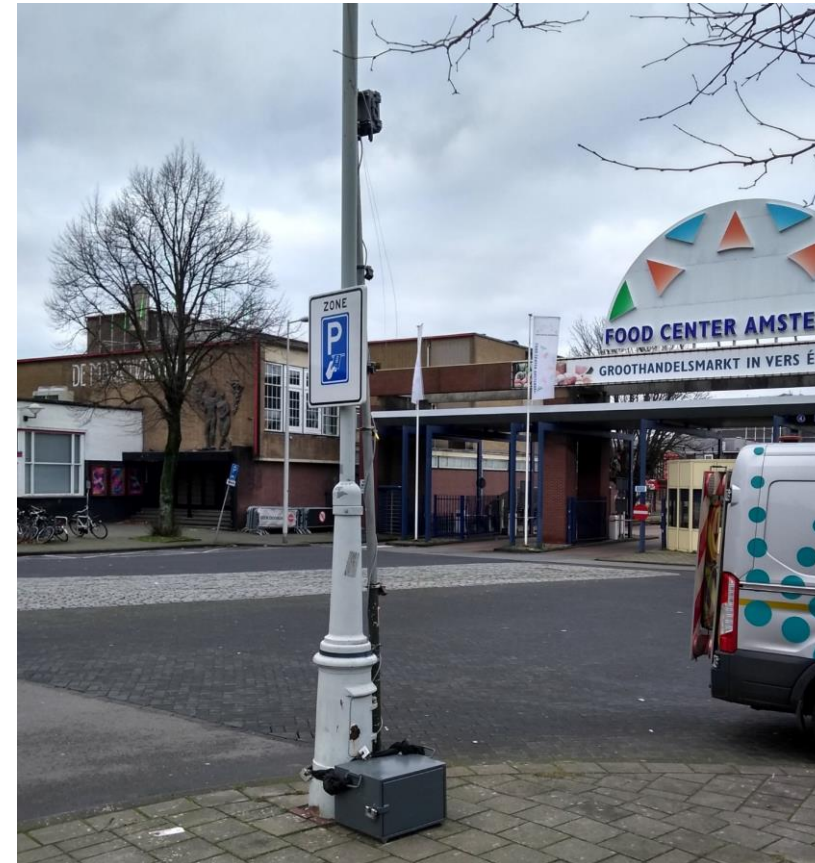
Foto: gebruikte apparatuur bij de zuidelijke entree van het FCA-terrein
