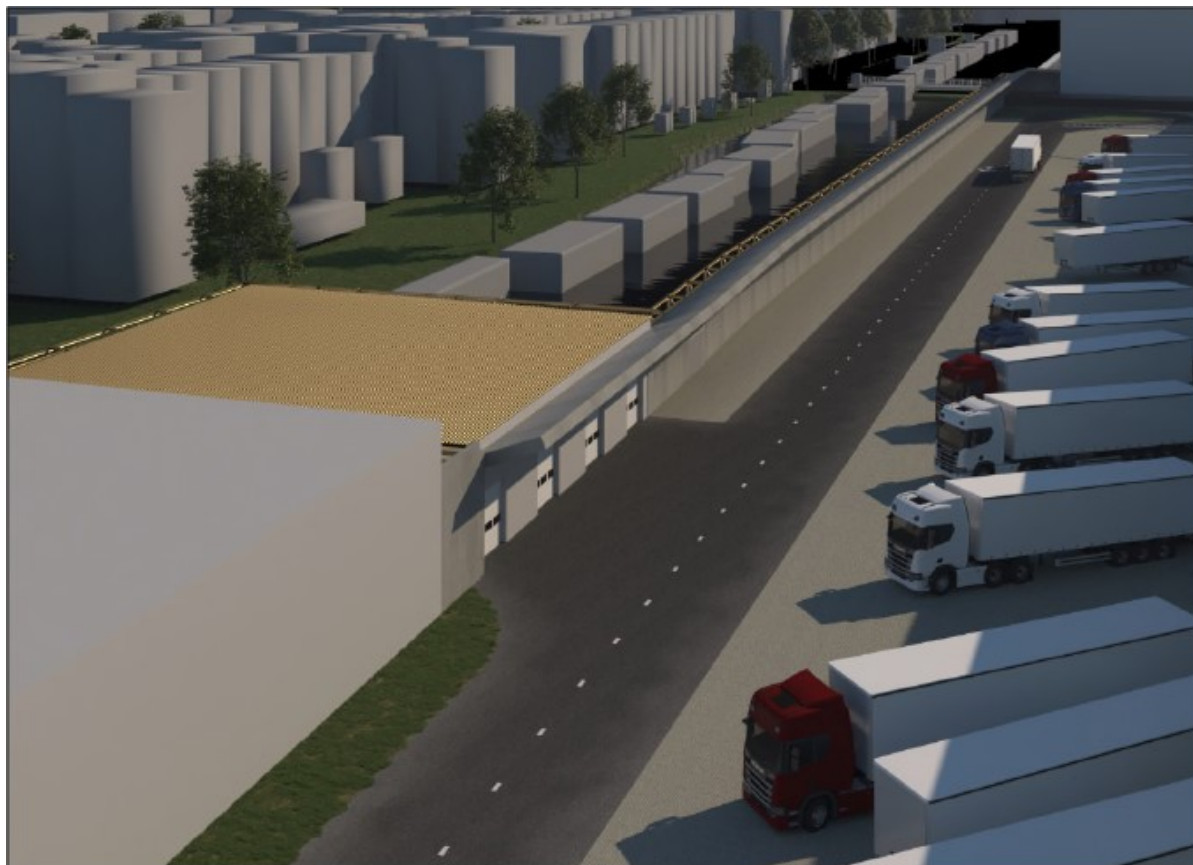
Afbeelding: visualisatie geluidscherm met luifel overhang langs de oostelijke expeditiestraat
