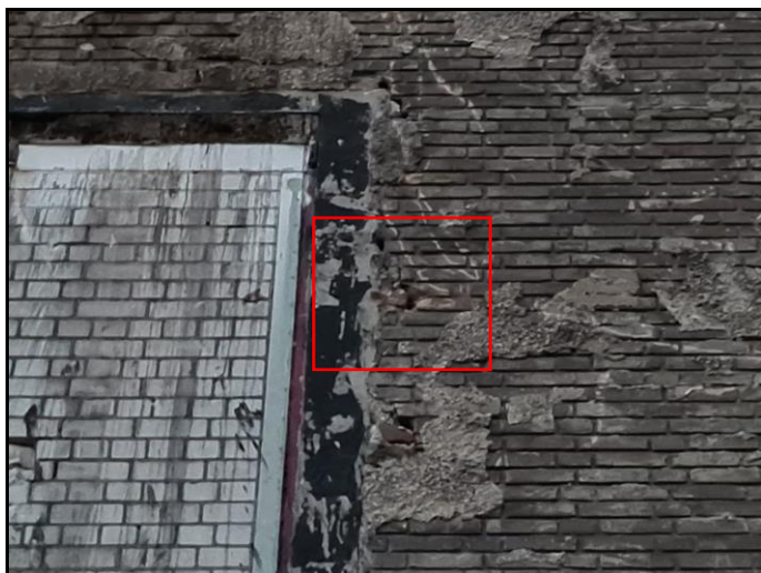
Afbeelding 1: Locatie zomerverblijfplaats voormalige centrale koelhuis
