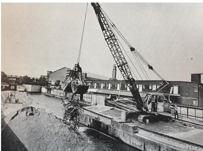
Figuur 3: Historisch foto met demping één van de insteekhavens met zand aangevoerd per schip (Bron: boek Amsterdam Marktstad; foto van Dienst van het Marktwezen).
