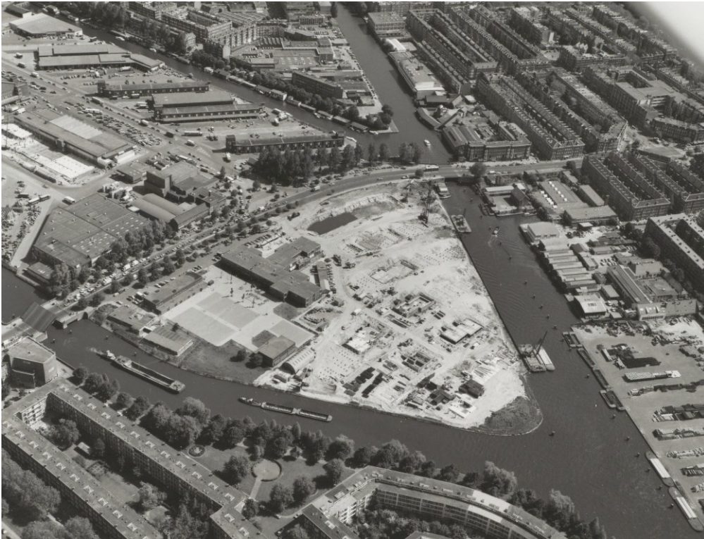
Afbeelding: Luchtfoto uit 1983. Te zien is hoe het plangebied in aanbouw is. De noodschool is op dat moment al voltooid. Bron: SAA B00000036425, 1983
