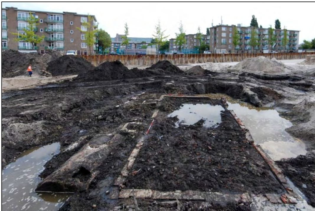
9 Het rechthoekige gebouw met een waterkelder en uitbouwen aan de linkerkant, gezien richting het oosten.
