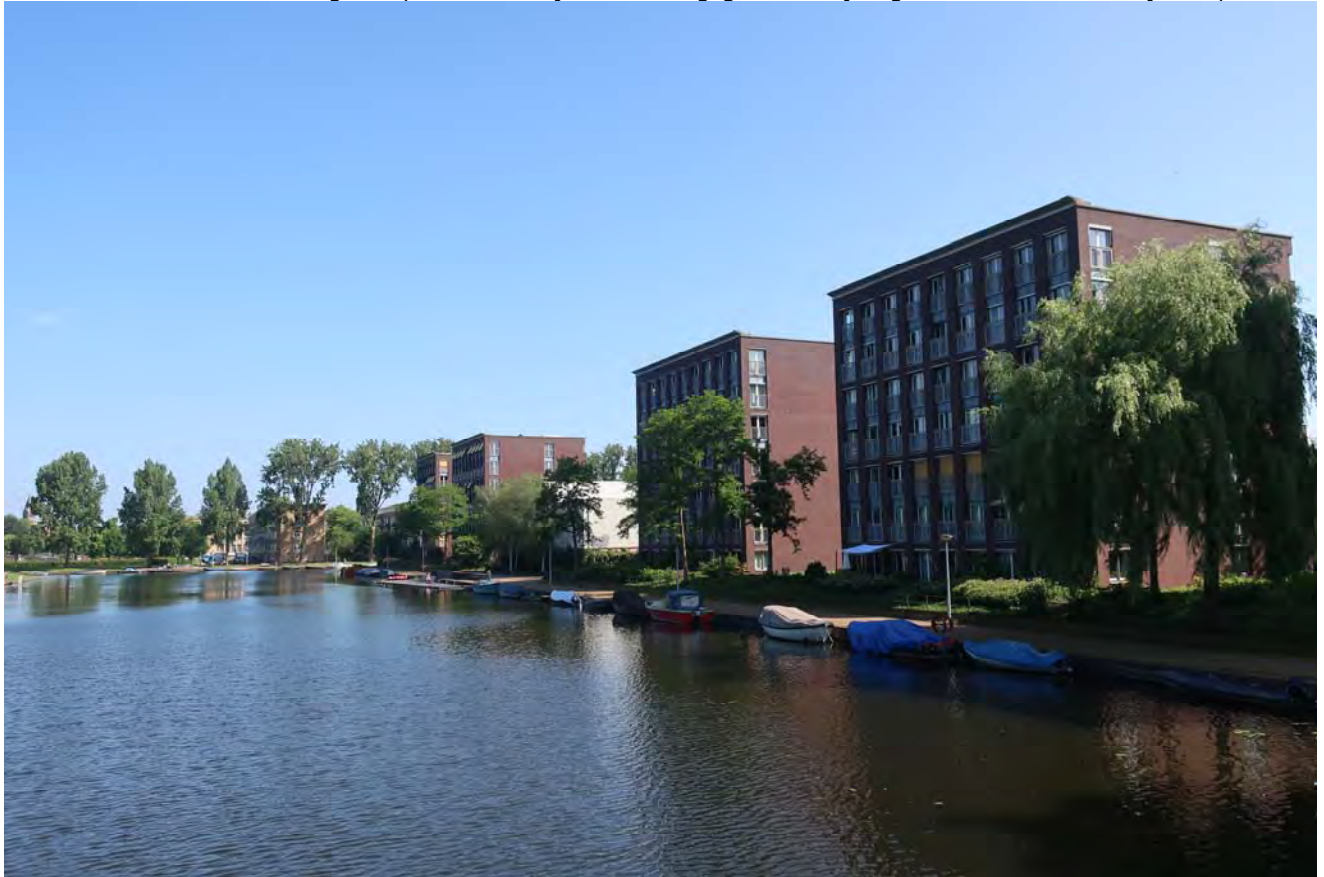
De nieuwbouw aan de Erasmusgracht pakt het motief van ritmering, groene omlijstingen en uitstekende daklijsten op.
