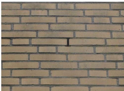
Figuur 5.4. Stootvoeg in een gebouw in het plangebied.
