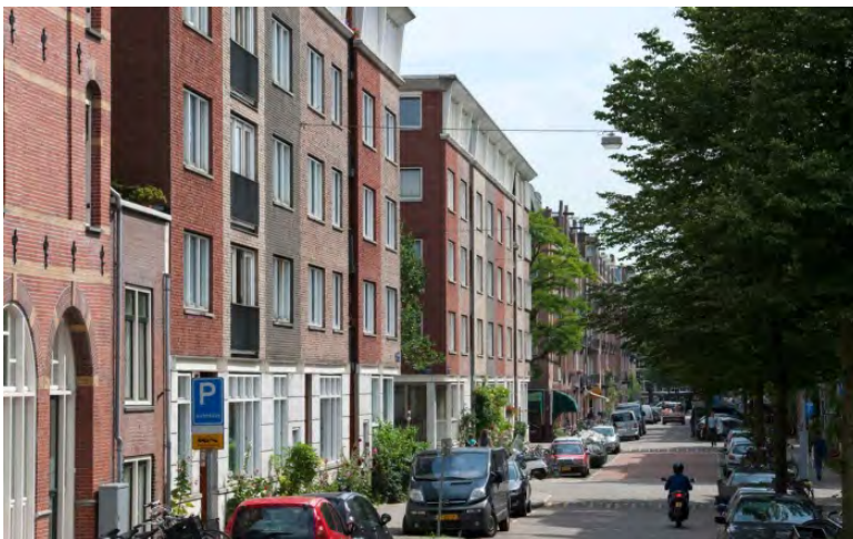
Woningbouw, Peter Geusebroek Verheij architecten
