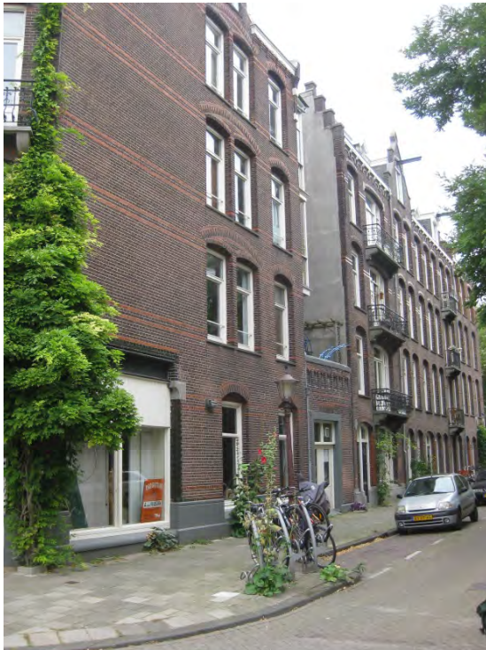
Opening voor lichtinval achter de kopbebouwing
