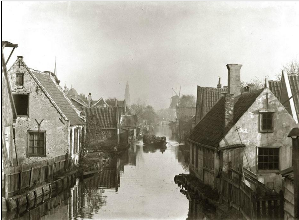
7 De Lange Bleekerssloot in 1890. Na de demping van de sloot en sloop van de bebouwing werd dit in 1895 de De Clerqstraat. Foto door Jacob Olie (SAA).
