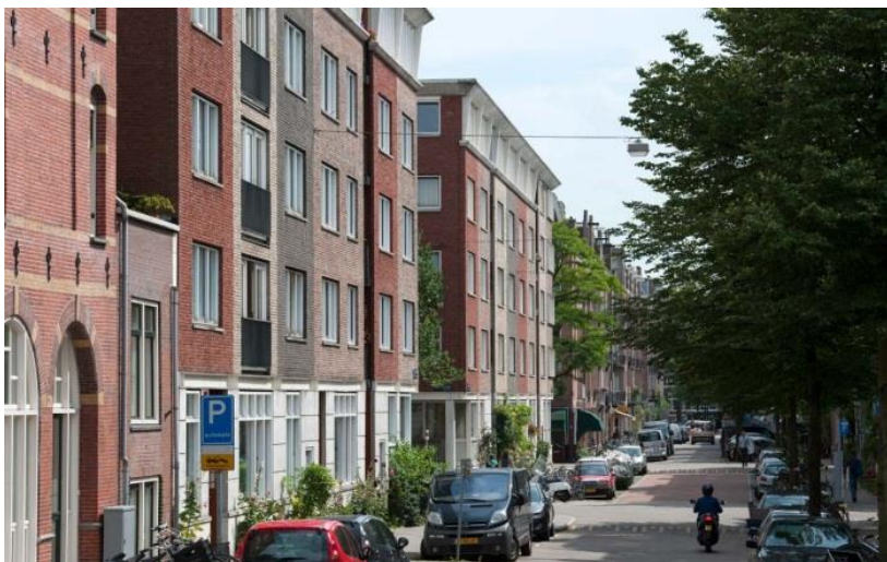
Woningbouw, Peter Geusebroek Verheij architecten,
