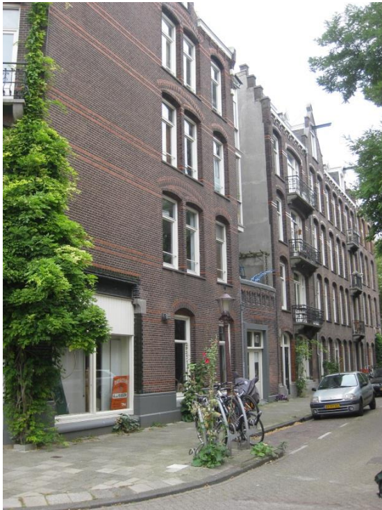
Opening voor lichtinval achter de kopbebouwing
