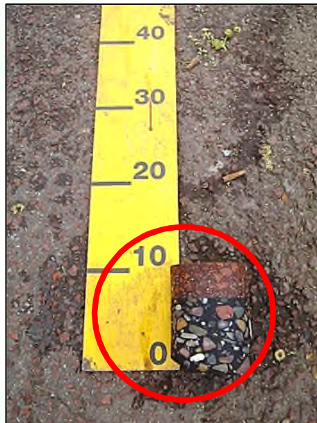
Eén van de verrichte asfaltboringen.
