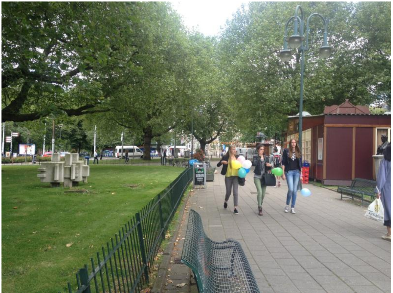
Fig. 3 Het voetpad, waarnaast het fietspad wordt aangelegd
