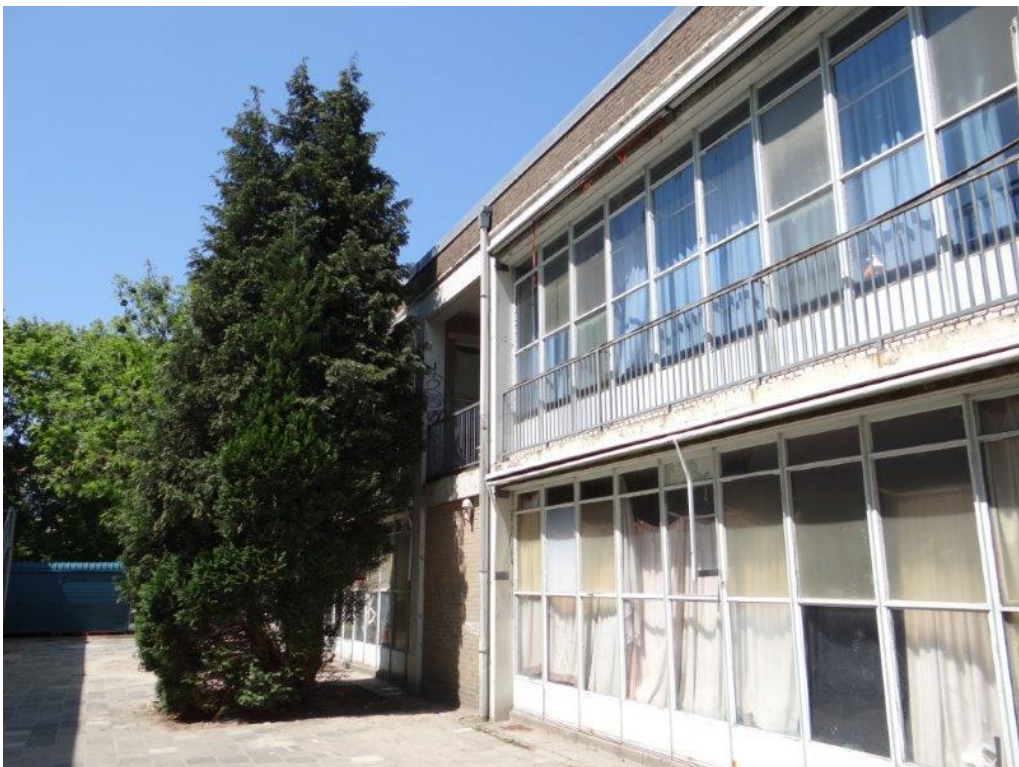
Foto 2 De achterzijde (zuidkant) van het bestaande schoolgebouw met zicht op de binnenplaats.
