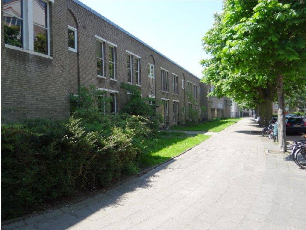
Foto 1 Zicht op de voorzijde van het gebouw (Amundsenweg).
