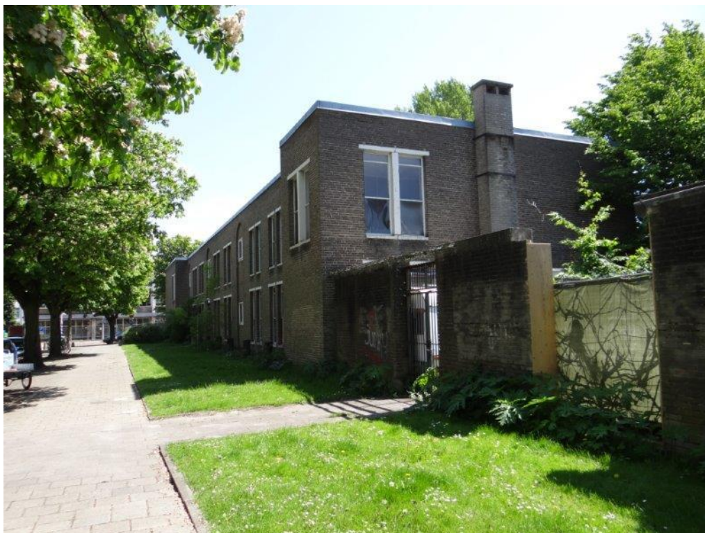
Foto 1. Het schoolgebouw Amundsenweg 1, aanblik vanaf de westzijde
