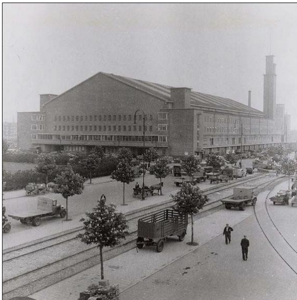
Afbeelding: foto van de Centrale Markthal in 1948 met rechts de toenmalige klokkentoren (bron Notitie Centrale Markthal Amsterdam, BMA, september 2009/Beeldbank Stadsarchief Amsterdam)
