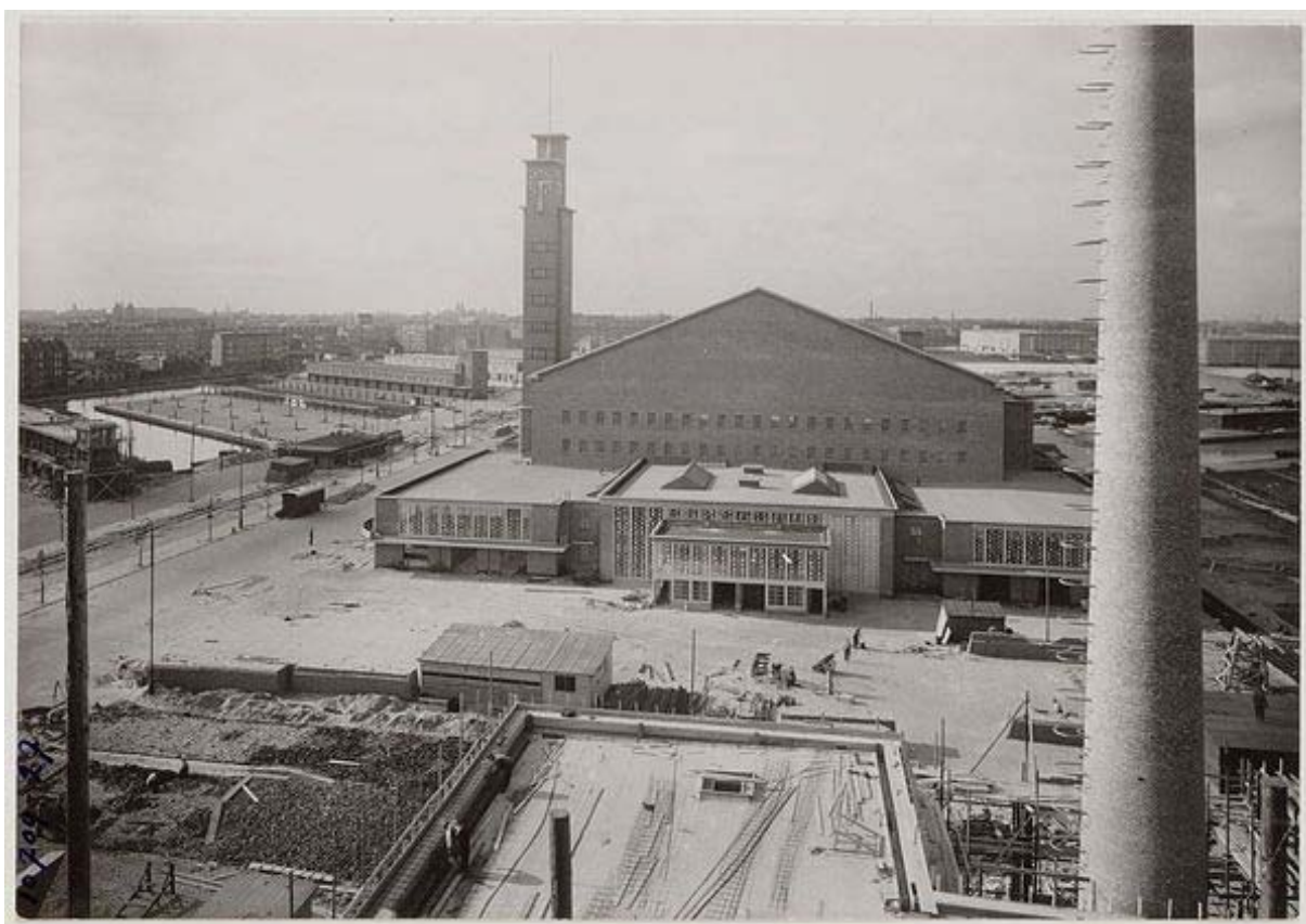
Overzicht Centrale Markterrein in aanbouw gezien vanaf de koelhal, 4 juli 1934, (beeldbank SAA)
