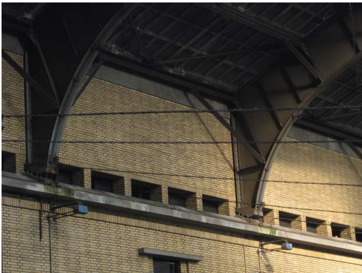
Centrale Markthal, kapconstructie in westelijke zijgevel, april 2009 (BMA)
