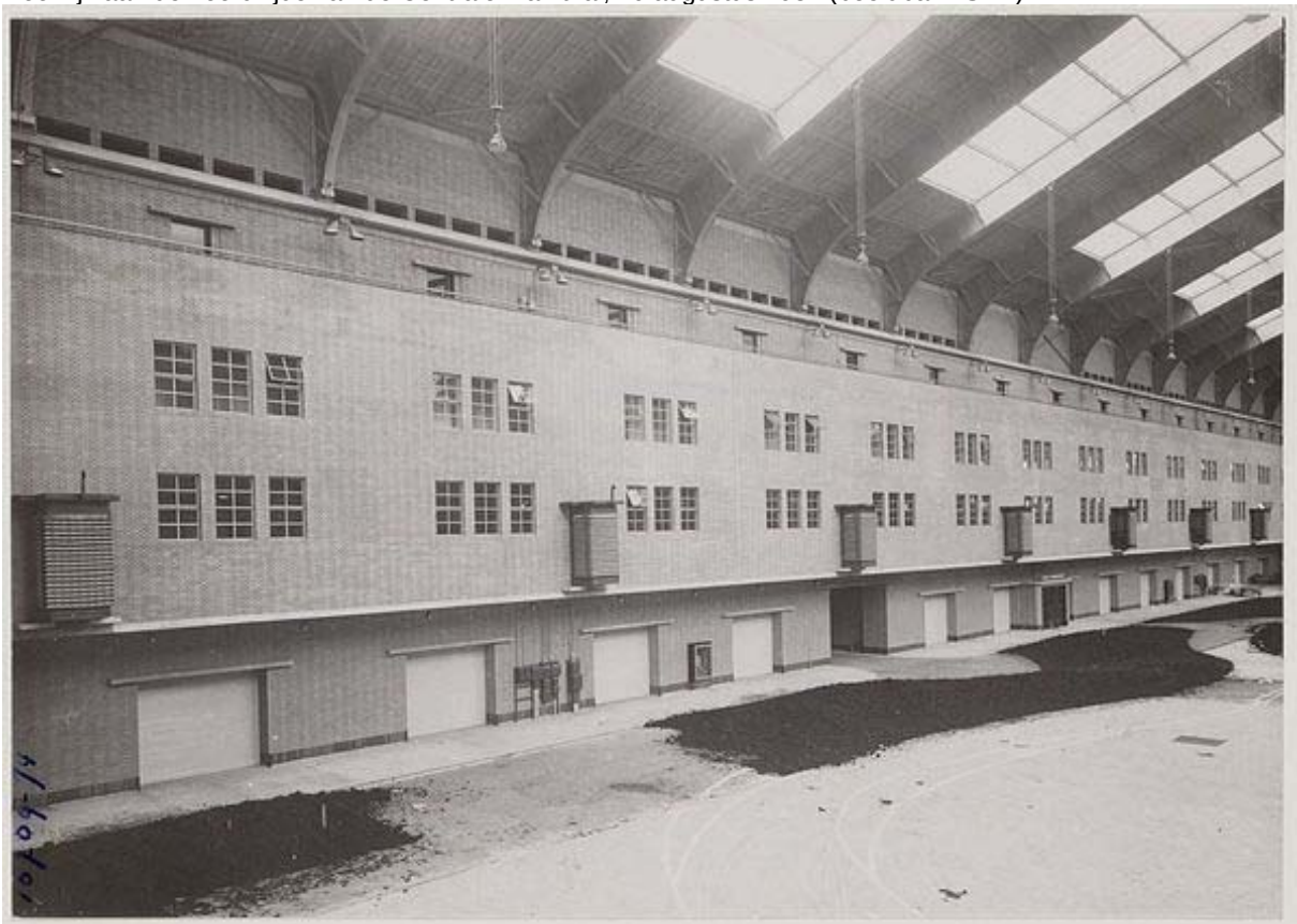
Afwerkingsfase Centrale Markthal, ongedateerd (beeldbank SAA)
