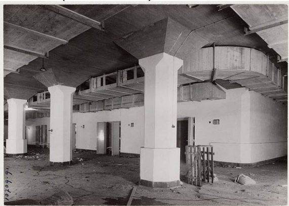
Interieur met houten ventilatieschachten op een van de verdiepingen in de koelhal tijdens de afwerkingsfase, 15 januari 1935 (beeldbank SAA)
