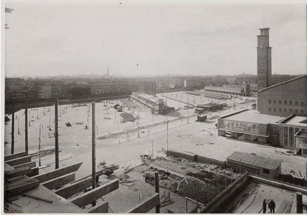
Overzicht markthallen met de fruit- en groentepakhuizen in aanbouw. Gezien vanaf de koelhal, 4 juli 1934 (beeldbank SAA)
