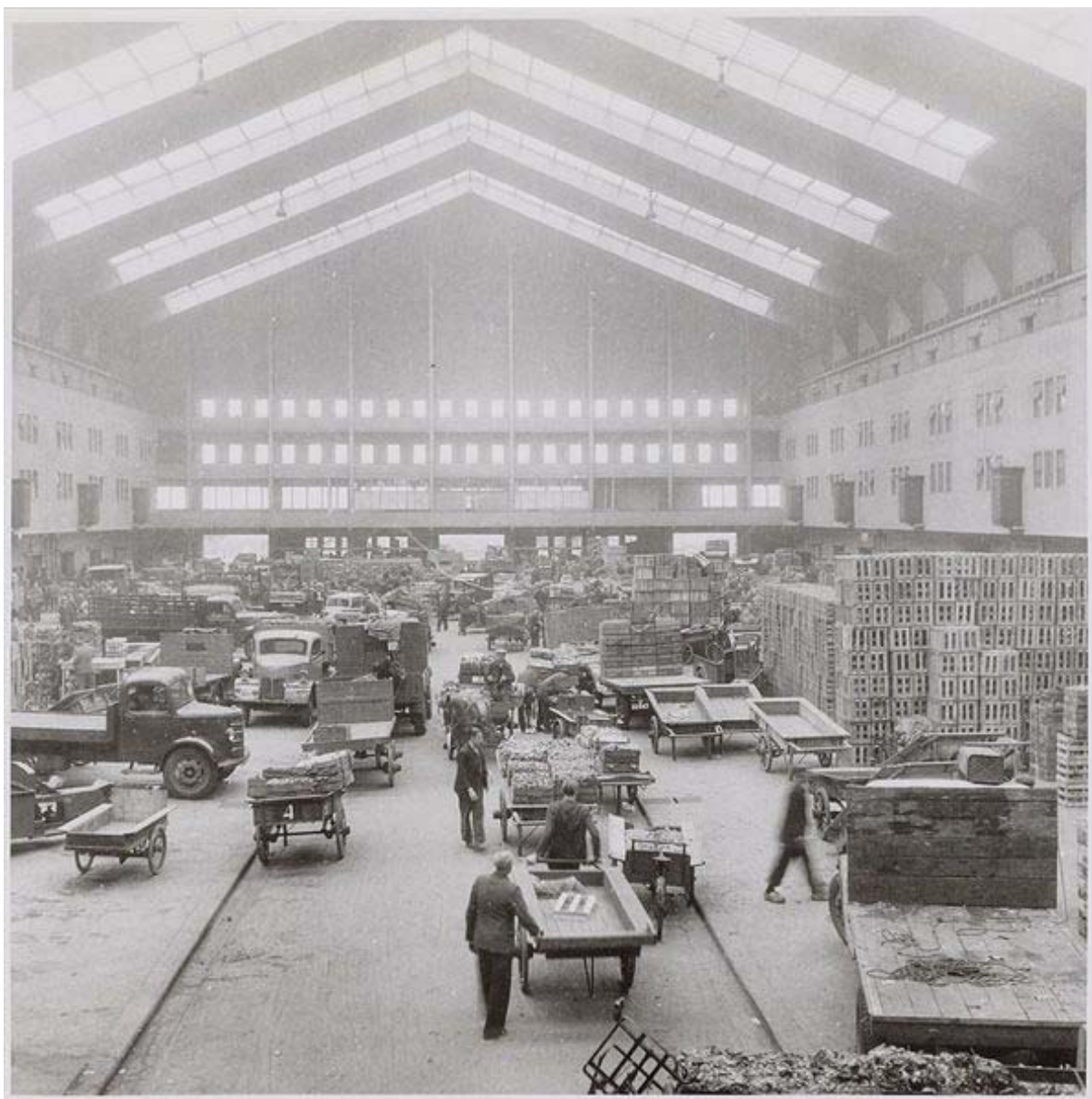
Centrale Markthal in gebruik, mei 1948 (beeldbank SAA)
