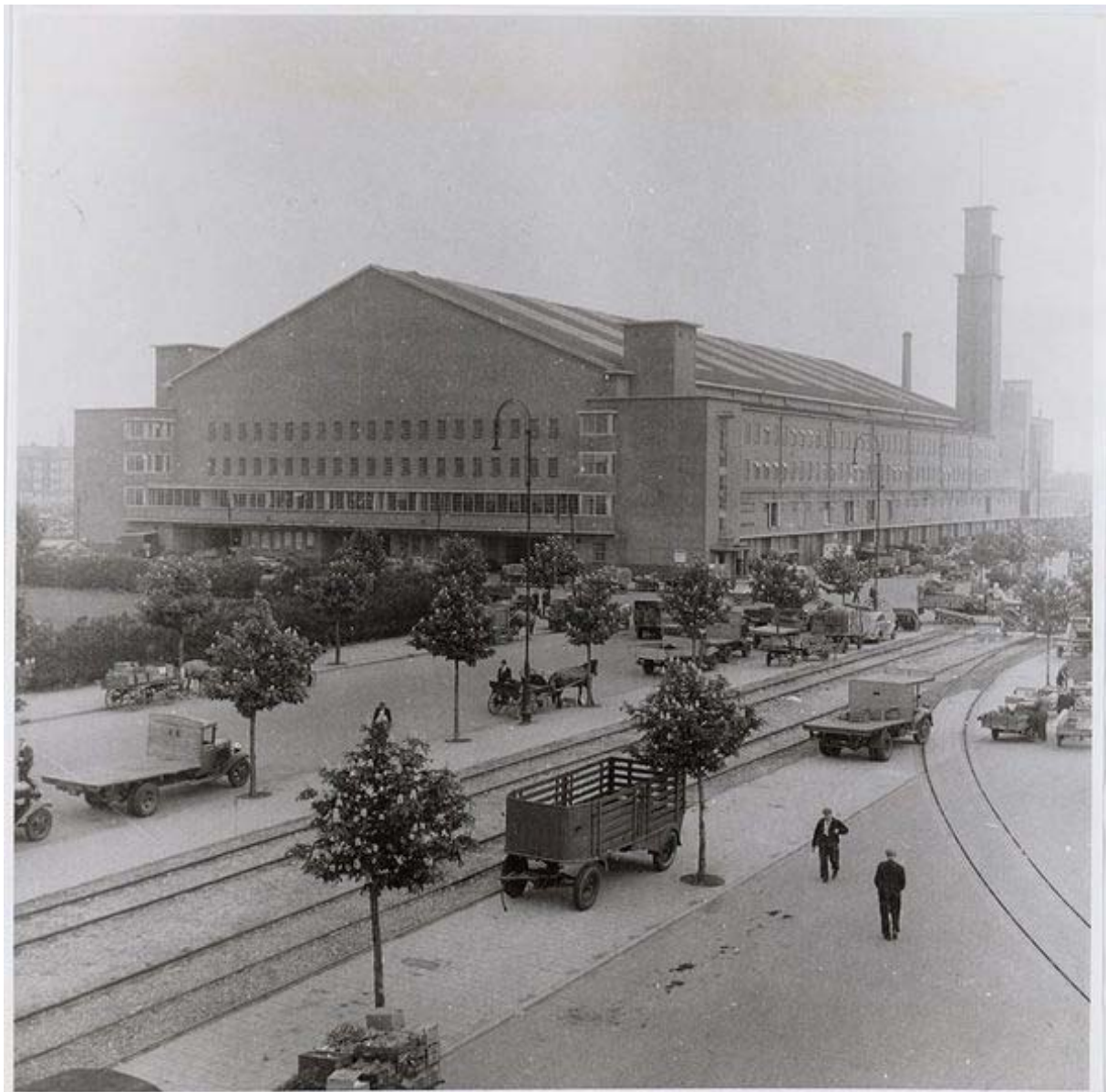
Overzicht Centrale Markthal met spoor-raccordement, mei 1948 (beeldbank SAA)
