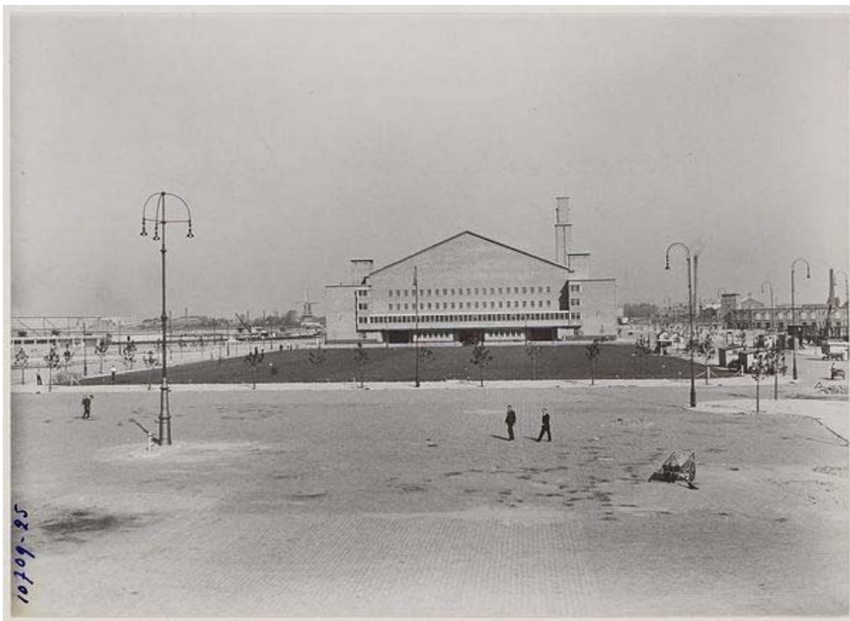
De Centrale Markthal, 8 september 1934 (beeldbank SAA)
