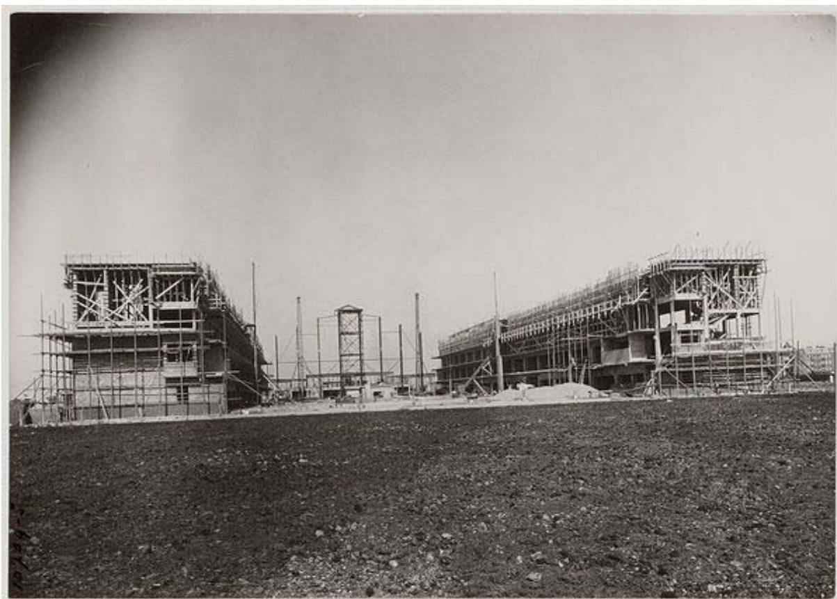
Centrale Markthal in aanbouw, 28 augustus 1934 (beeldbank SAA)
