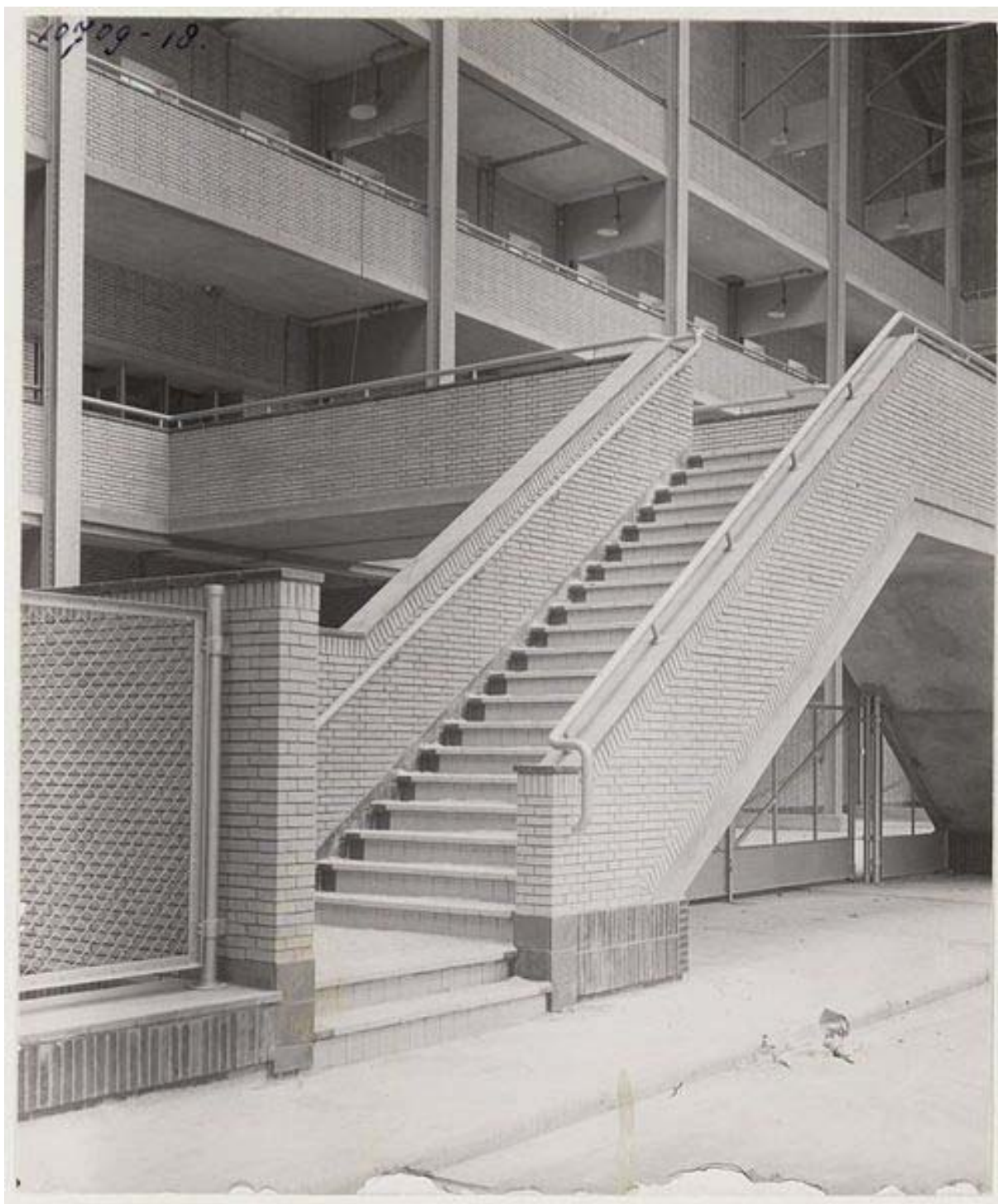
Centrale Markthal, de trap in de grote hal in aanbouw, 10 augustus 1934 (beeldbank SAA)
