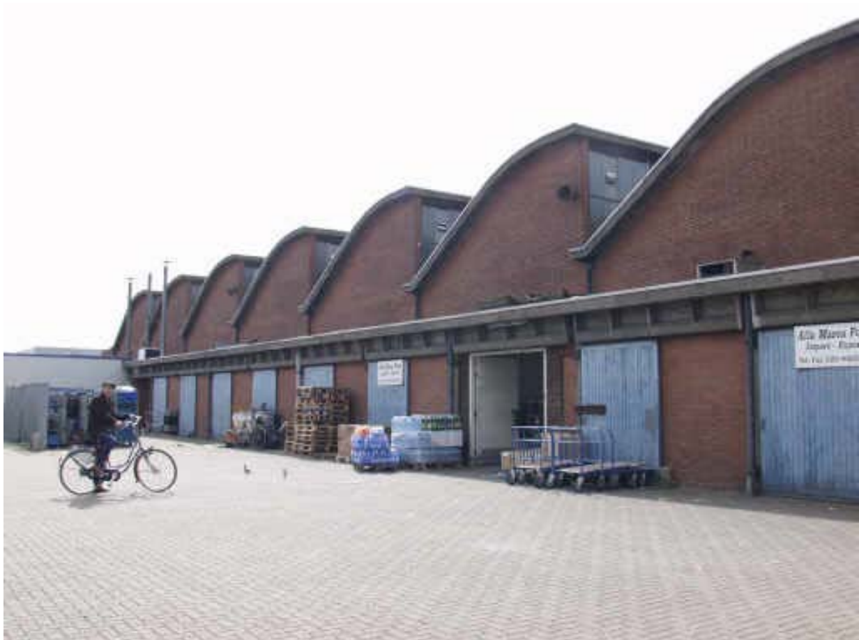
Oostelijke gevelwand vishal, (BMA, 2005)
