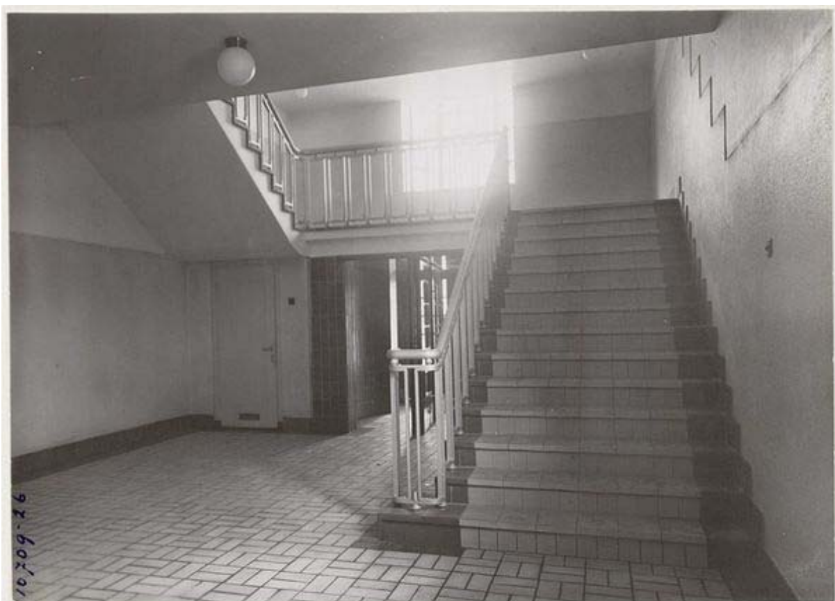
Trapportaal zuidoostelijk zijde (hoofdtrappenhuis) Centrale Markthal, 9 augustus 1934, (beeldbank SAA) -Nog intact april 2009
