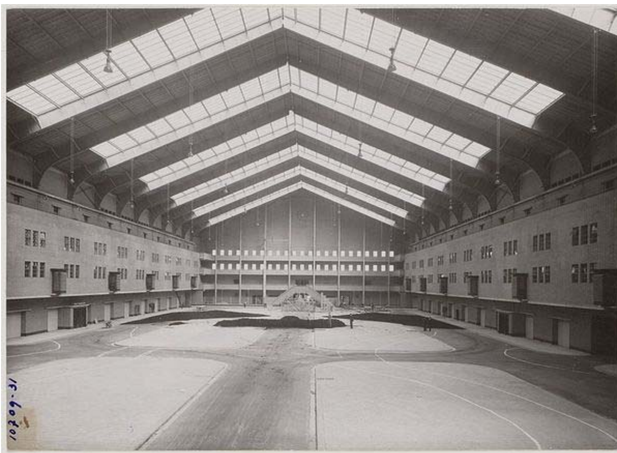
De grote hal van de Centrale Markthal in aanbouw, 5 juli 1934 (beeldbank SAA)
