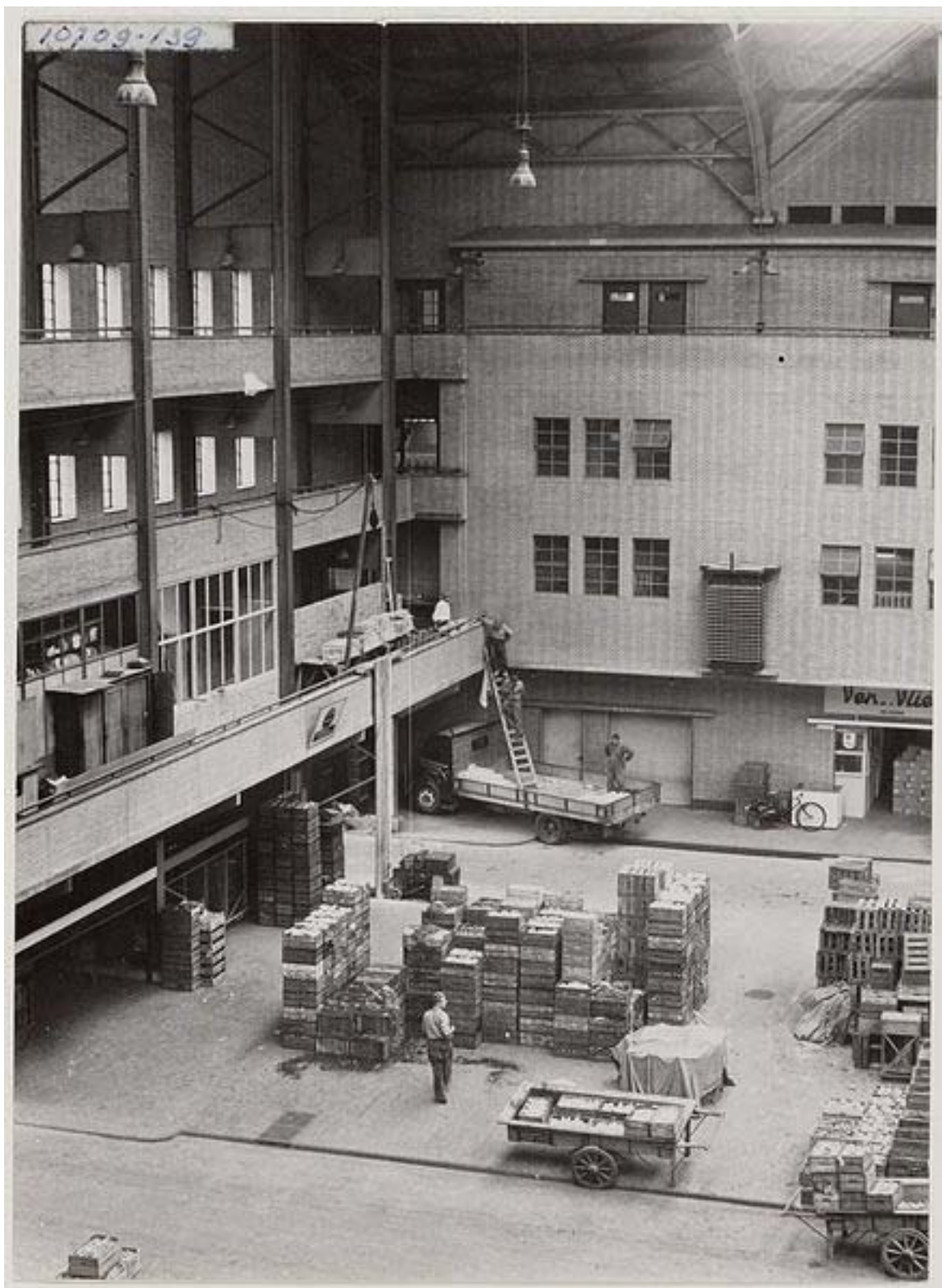
Centrale Markthal, verhoging van de zuidelijke inrit met verbouwing van de daarboven gelegen kantoren, 23 juli 1953, (beeldbank SAA).
