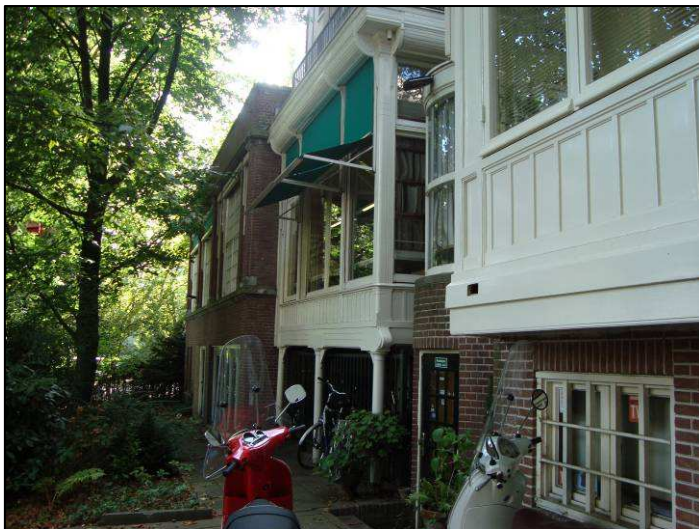
Afbeelding: huidige situatie: diverse aan- en uitbouwen aan de achterzijde van het pand.
