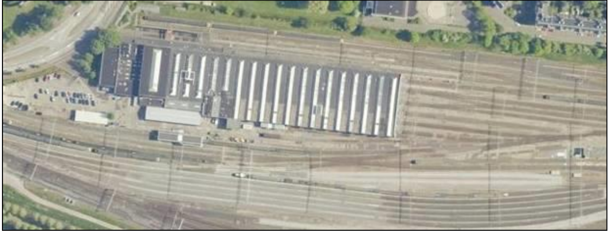
Afbeelding: het rangeerterrein en de voormalige werkplaats van Nedtrain aan de Zaanstraat
