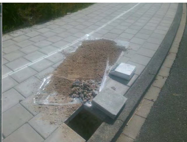
Foto 6: Asbestinspectiegat AB22
