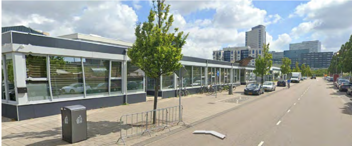
Afbeelding: huidige bedrijfsbebouwing langs de Rhoneweg
