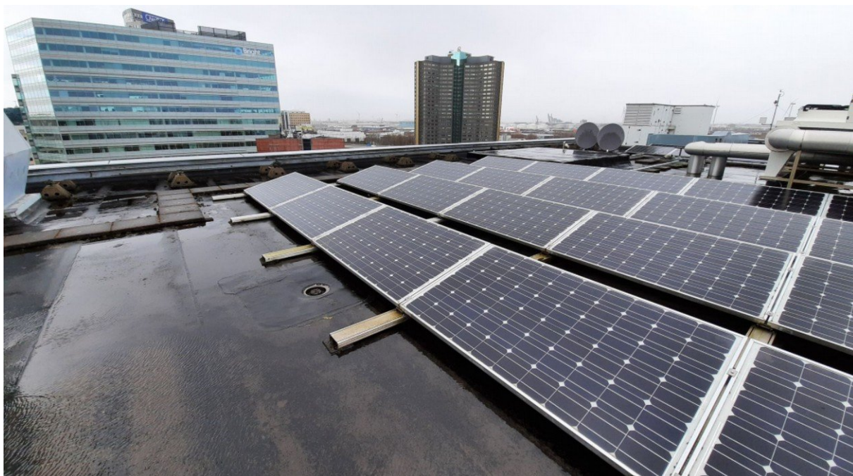
Overzicht dakvlak. Foto: B. Verhoeven | Ecoresult B.V.
