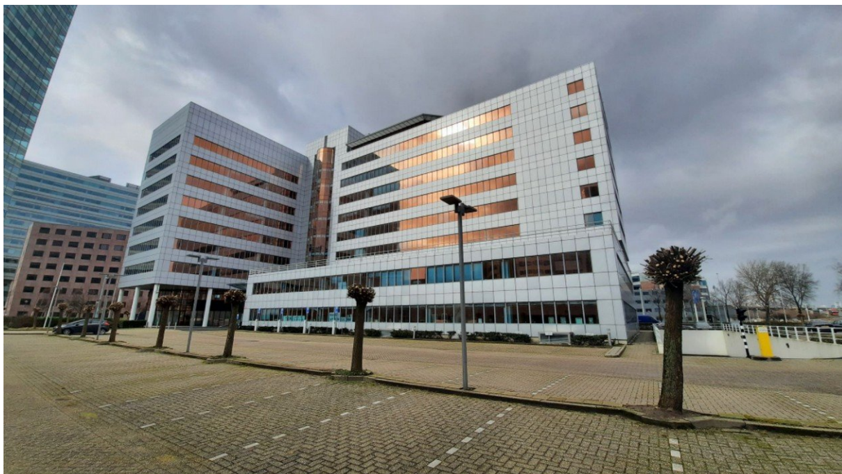
Overzicht bebouwing en omliggend terrein. Foto: B. Verhoeven | Ecoresult B.V.
