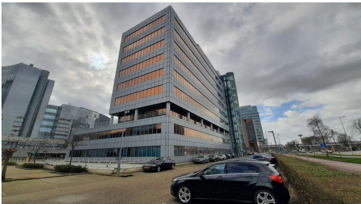
Overzicht bebouwing (noordelijke en oostelijke gevel). Foto: B. Verhoeven | Ecoresult B.V.
