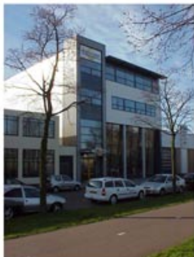
Voorbeeld van hogere bouwhoogte in westelijk deel van Sierdijk 8 Zuid; het bedrijf Truckland heeft een front met showroom en (beperkte) kantoorruimte en de bedrijfspaal daarachter
