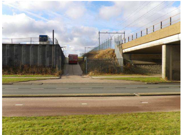
Foto 10: Overzicht toegang metro opstelrein
