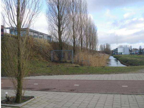
Foto 1: Overzicht nabij onderdoorgang
