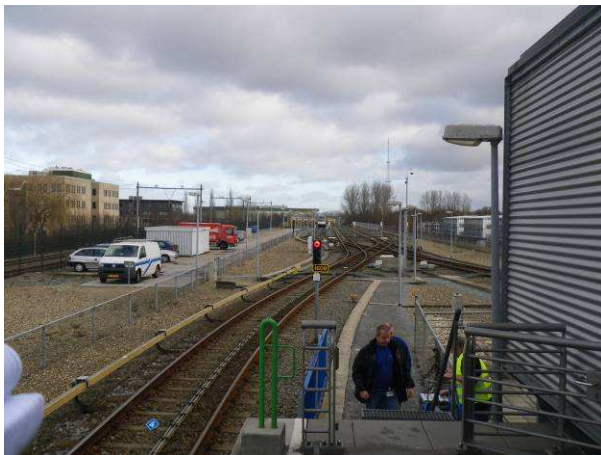
Foto 11: Overzicht metro opstelrein
