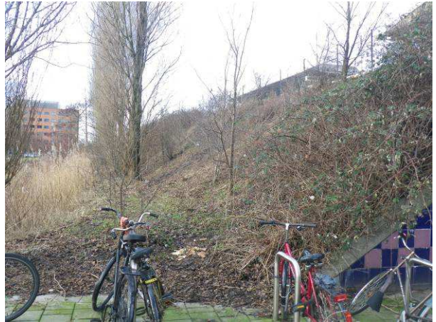
Foto 2: Talud bij onderdoorgang
