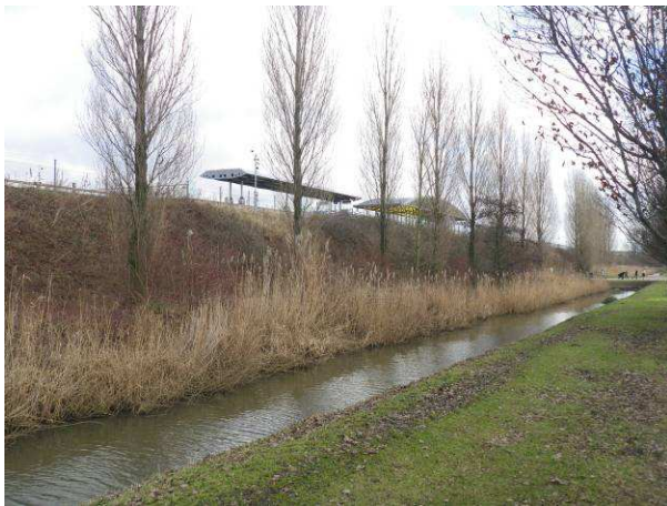
Foto 3: Overzicht talud zuidelijk deel
