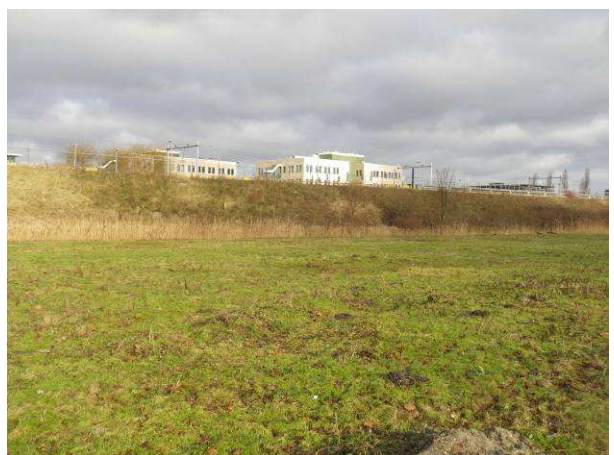
Foto 6: Overzicht taluds zuidwestelijk deel
