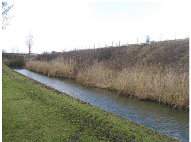
Foto 4: Overzicht talud zuidelijk deel
