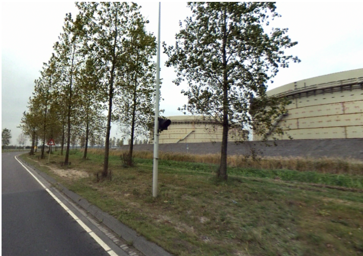
Olieterminal VOPAK in aanbouw
