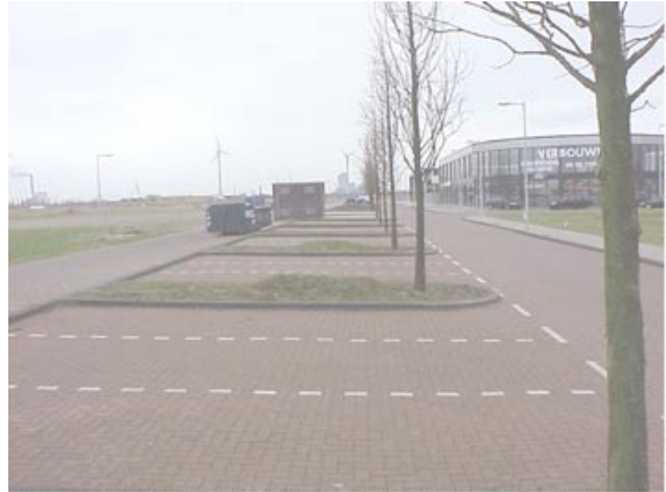
De laan Sierenhof, 'de auto- en woonboulevard', wordt één van de toekomstige concentratieplekken in de openbare ruimte van de Slotendijk (hier nog slechts het halve profiel aangelegd). Dit vraagt om extra investeringen: voorgesteld wordt het tráfichuize te verplaatsen naar één van de bouwkeuzes en de huidige boomtypen alsnog te vervangen voor een dubbele rij platanen
