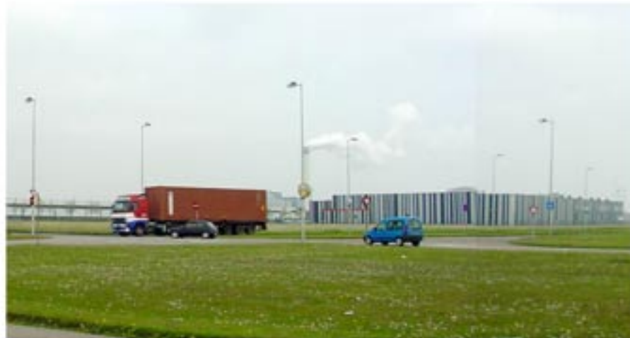
Bestaande distributieloodsen in Sloterdijk III Noord
