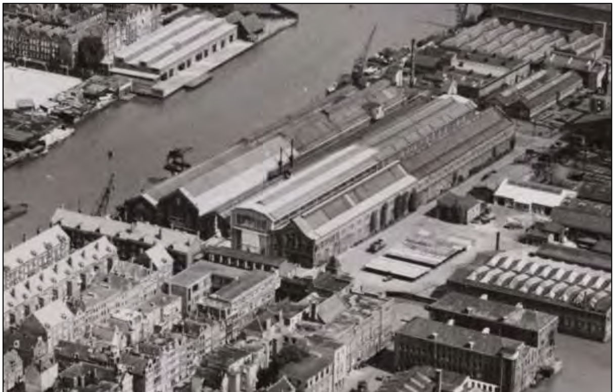
Afbeelding: luchtfoto van de vijf hallen (zuidelijke en oostelijke gevels) na verlenging van hal 4, 1938 (bron: SAA)
