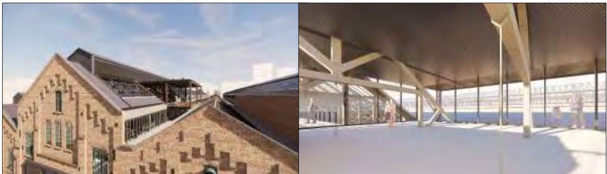
Afbeelding: de dakkapel van buitenaf gezien (links) en het zicht vanuit de kantoorruimte met dakkapel door de spanten
