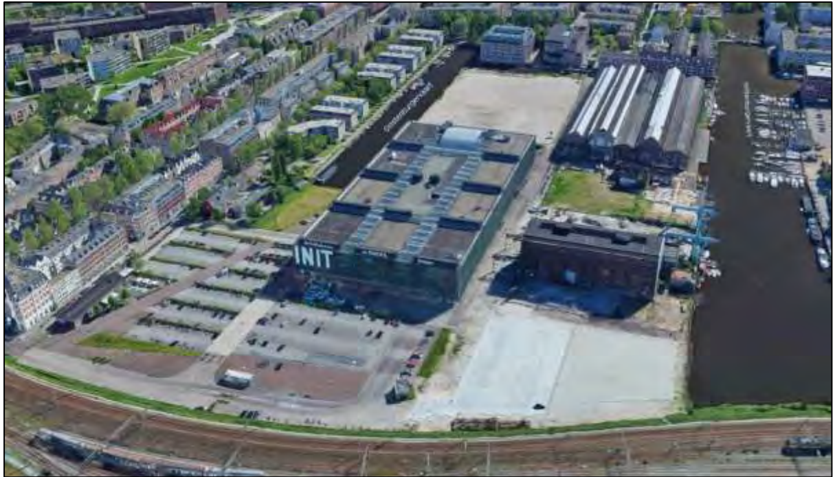
Afbeelding: Stadswerf Oostenburg in vogelvucht, gezien vanuit noordelijke richting en voorafgaand aan de inmiddels gestarte bouwactiviteiten (bron: Google Earth)
