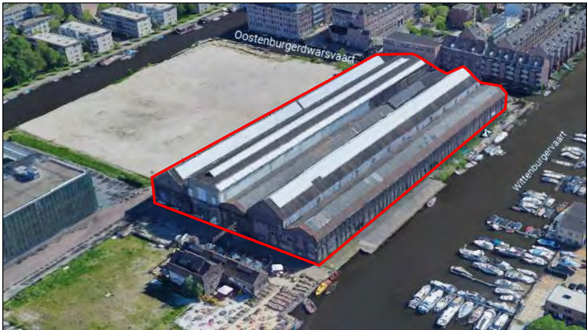
Afbeelding: de met rode lijn aangegeven Van Gendthallen in vogelvlucht, gezien vanuit noordelijke richting (bron: Google Earth)
