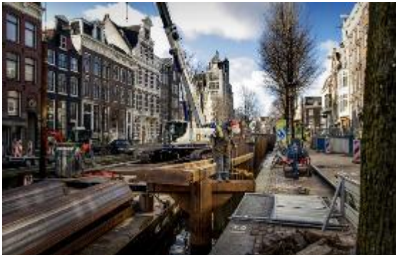
Voorbeeld gebruik dekschuiten bij kadevernieuwing in de binnenstad
