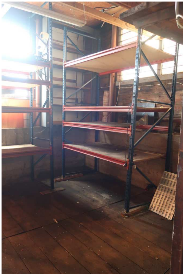
Gebouw rechtmidden, magazijn, naar zijgevel rechts (Entrepotdoksluis) en voorgevel (Hoogte Kadijk)
