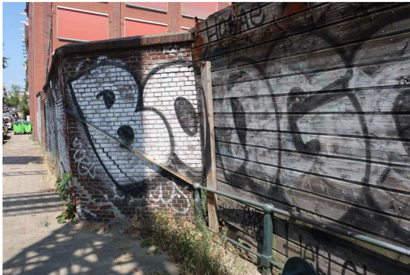
Hoogte Kadijk, aansluiting muur bij brug 80.
