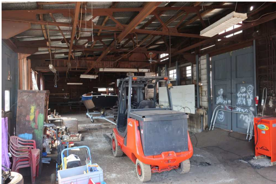
Gebouw rechtmidden, werkplaats, naar voren (magazijn en Hoogte Kadijk)
