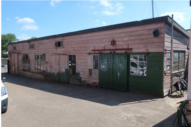
Gebouw rechtmidden, werkplaats en magazijn, exterieur (naar Entrepotdoksuis)
