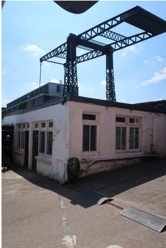
Gebouw rechtsvoor, exterieur (naar Hoogte Kadijk en naar Entrepotdoksluis)
