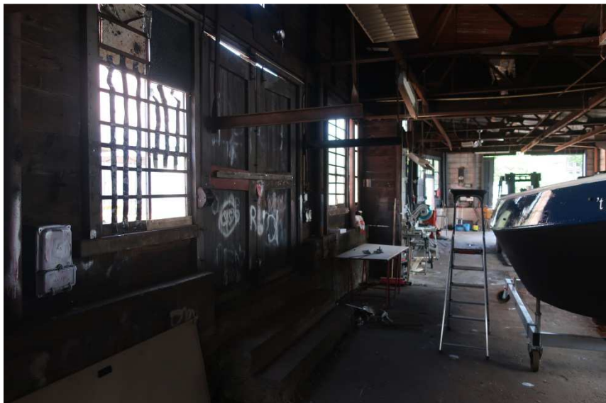
Gebouw rechtsmidden, werkplaats, zijgevel links, naar achteren (Nieuwe Vaart)
