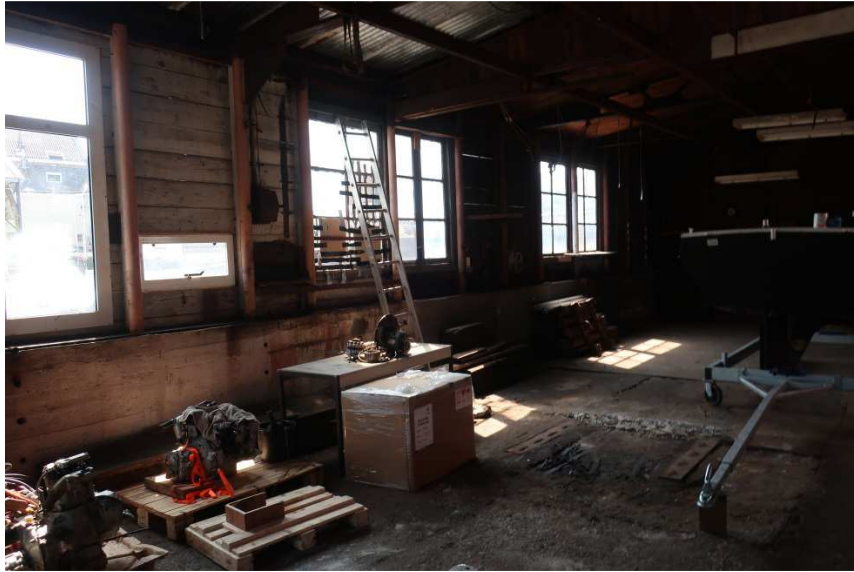
Gebouw rechtsmidden, werkplaats, zijgevel rechts (aan Entrepotdoksluis), naar voren (Hoogte Kadijk)
