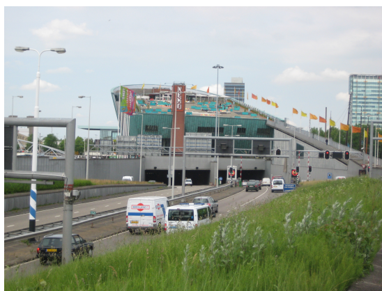
opgang IJtunnel - anno 2011
