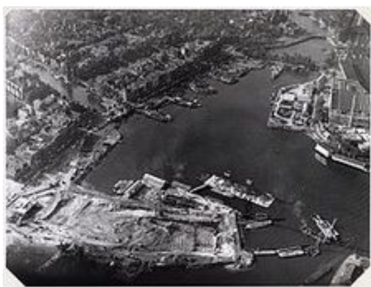
luchtfoto bouw IJtunnel - oktober 1965
