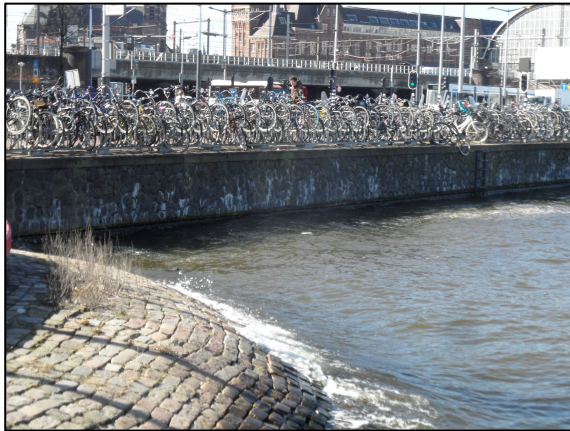
Foto 3 & 4. Steile kademuur met basaltblokken.
