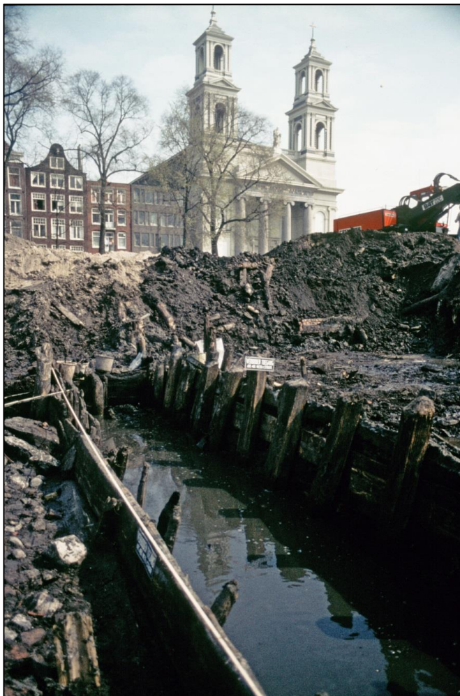
14 Kadewerken langs een ontginningsloot op het Waterlooplein (vindplaats WLO).
