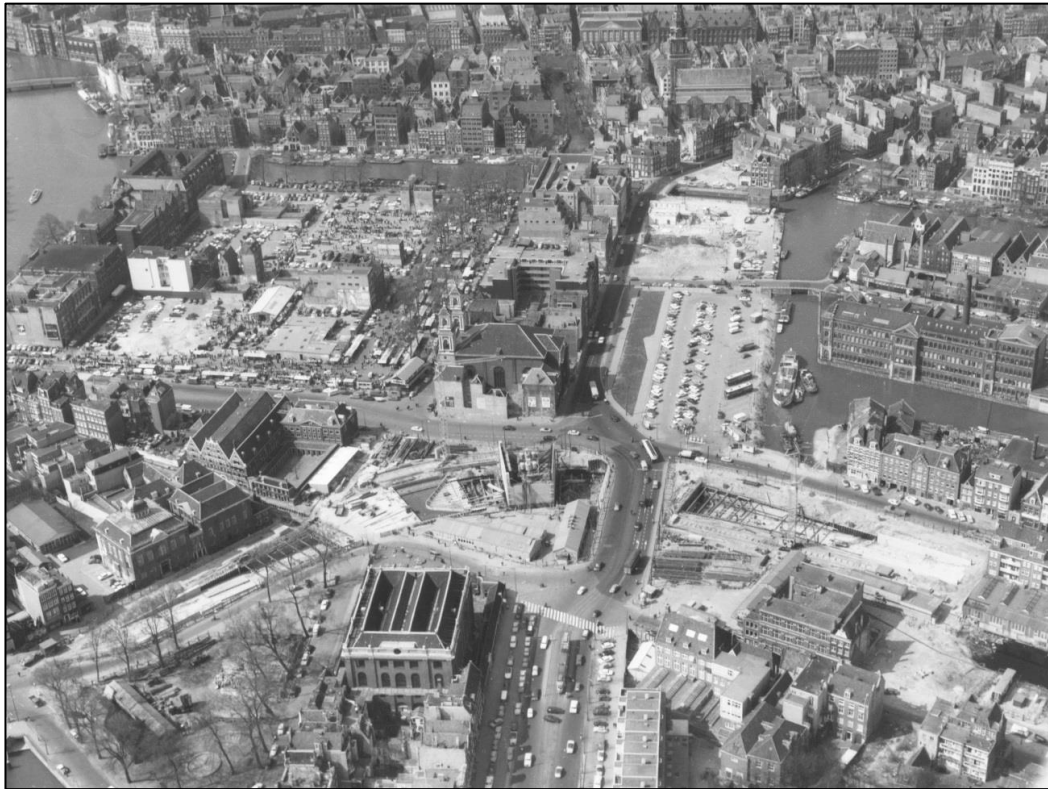
11 De bouw van de verkeersonderdoorgang onder het Mr. Visserplein ca. 1968 (SAA). Grote delen van de bebouwing op Vlooienburg en langs de Jodenbreestraat zijn reeds gesloopt.
