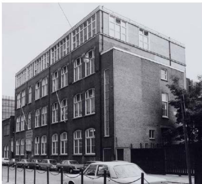
Foto na jaren '60 met de verhoogde zij-aanbouw en de nieuwe kapverdieping
