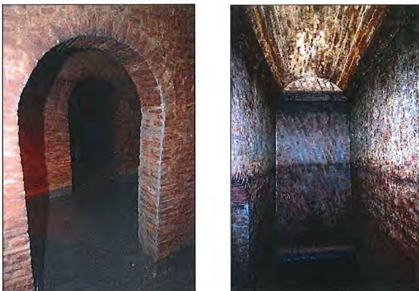
13 Een doorkijk door de compartimenten van de waterkelder onder weeshuis De Laurier, tijdens bouwwerkzaamheden in 2010 gedocumenteerd (LAU3)
