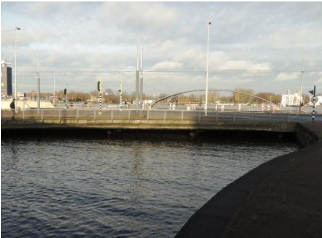
Huidige situatie autobrug De Ruijterkade over Oostertoeegang. De beperkte hoogte sluit de Oostertoeegang af voor scheepvaart.
