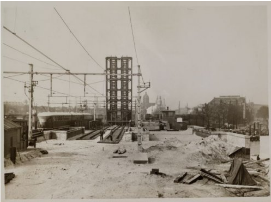
Beeldbank Stadsarchief 010003012860 - Plaatsing van drie nieuwe viaducten ca. 1938. Ook het brugwachtershuis is op de foto te zien.
