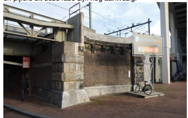
Het resterende gedeelte van het zuidoostelijke vleugelgebouw. Huidige toestand.
