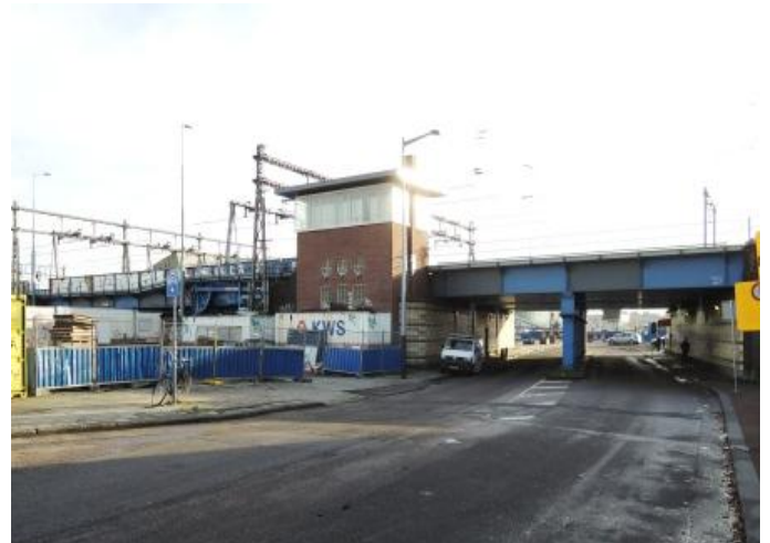
Spoorwegviaducten Oosterdoksdoorgang/De Ruijterkade en bijbehorend brugwachtershuis.
