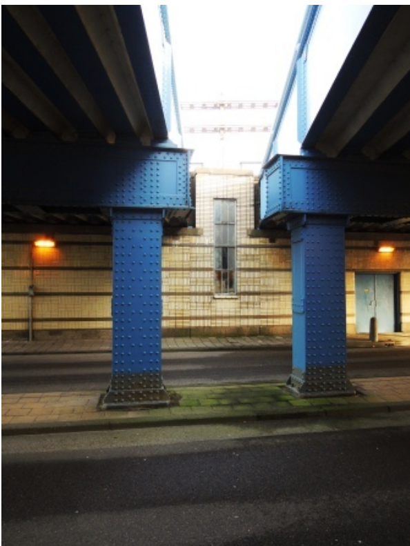
Onderbouw autotunnel t.h.v. De Ruijterkade/spoorwegviaduct Oosterdoksdoorgang.
