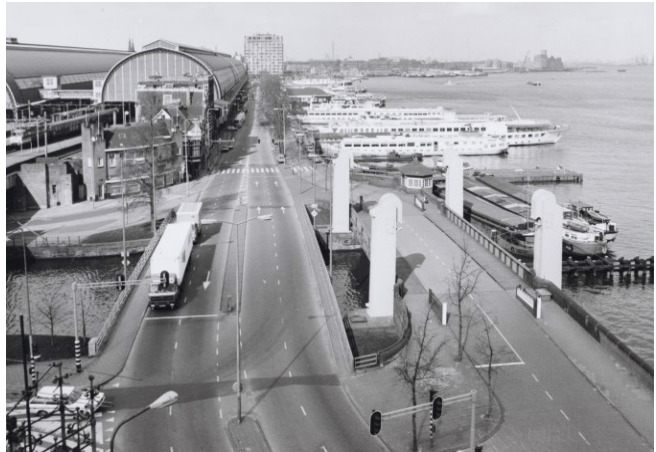
Beeldbank Stadsarchief B00000022149 – De betonnen brug uit 1973 naast de hefbrug uit 1930.
